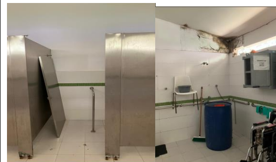
Sala Santa Catalina - desprendimiento de puerta y humedades en los baños
