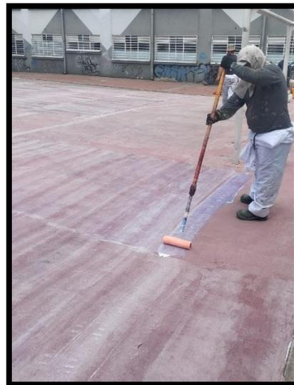
**7. Aplicación acabado color con recubrimiento acrílico con carga de arena de cuarzo.**
