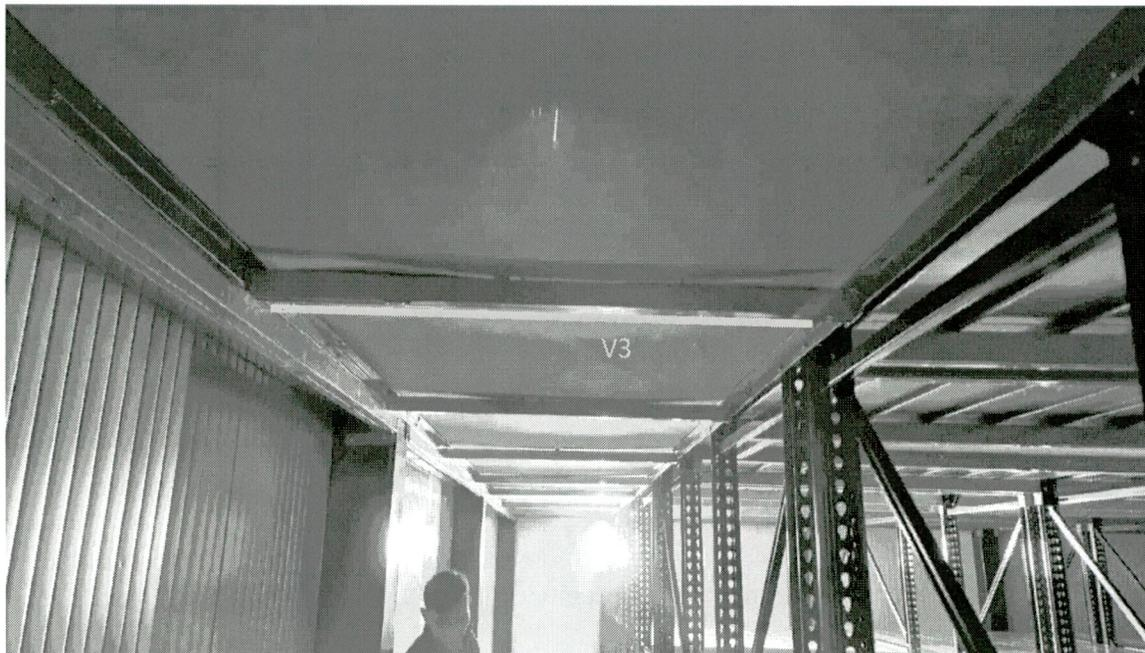
Se evidencia que el perfil V4 fue reemplazado por un ángulo, de igual forma fueron reemplazados los perfiles V3 y V1. Del perfil V3 se señala que debía tener una forma especial para facilitar la instalación del piso:
