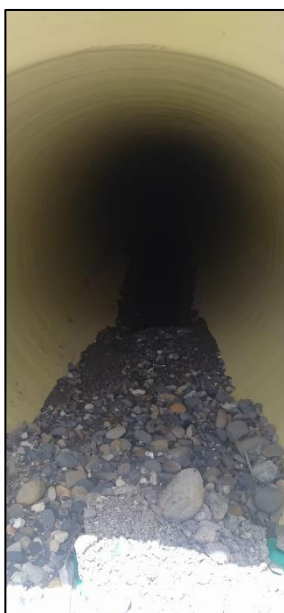
Material pétreo al interior tuberías instaladas. Estado de las obras
