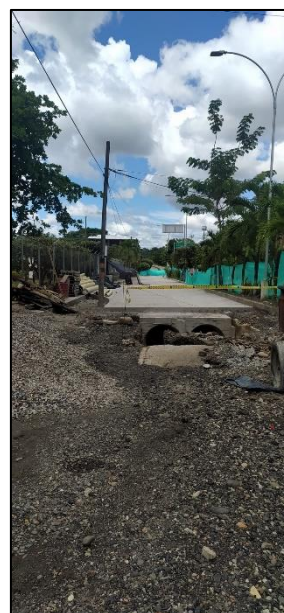
Material pétreo al interior tuberías instaladas. Estado de las obras
