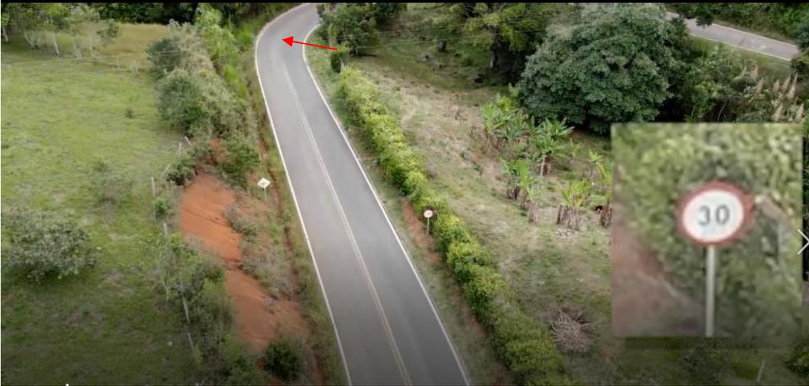
El mismo plano fotográfico permite observar una demarcación horizontal sobre la carpeta de rodado de asfalto en buenas condiciones, además se aprecia señal vertical reglamentaria SR 30, la cual indica la velocidad máxima de circulación en ese carril, sin embargo, en el punto de inicio de curva, no hay demarcación horizontal.
