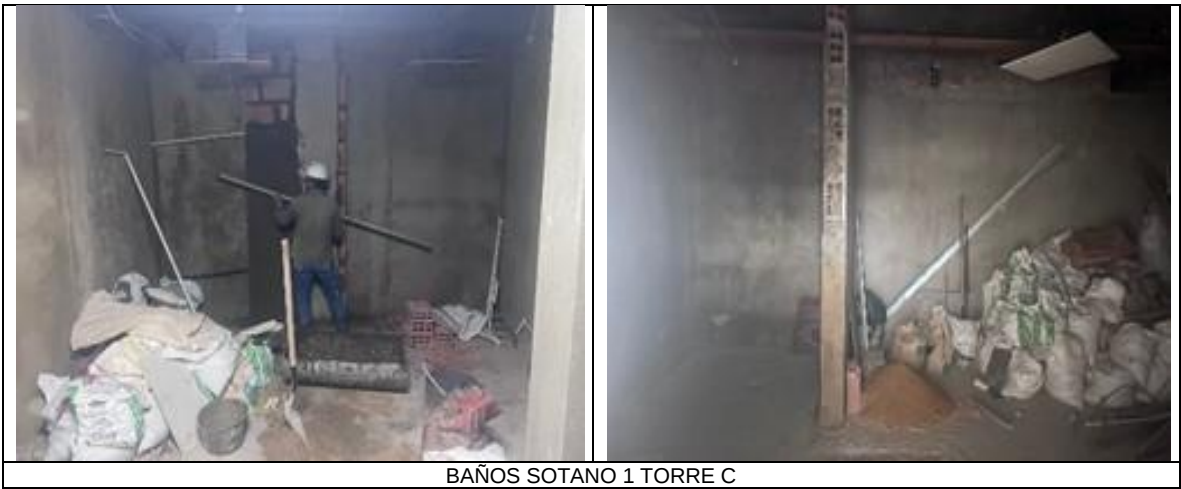
BAÑOS SOTANO 1 TORRE C
