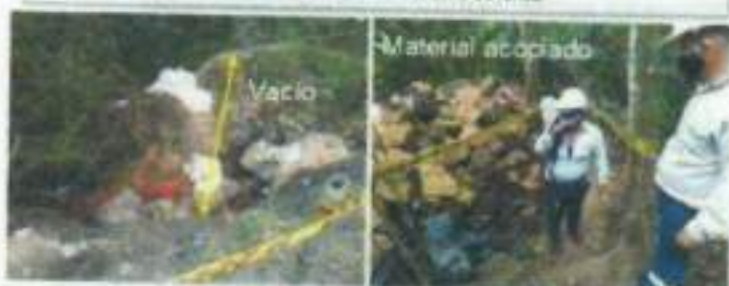
Fotografía 13 y 14. Material acopiado en la zona de ronda y que pueden generar peligro para trabajadores y comunidad, además se observa un vacío de aproximadamente 3 metros de altura.
