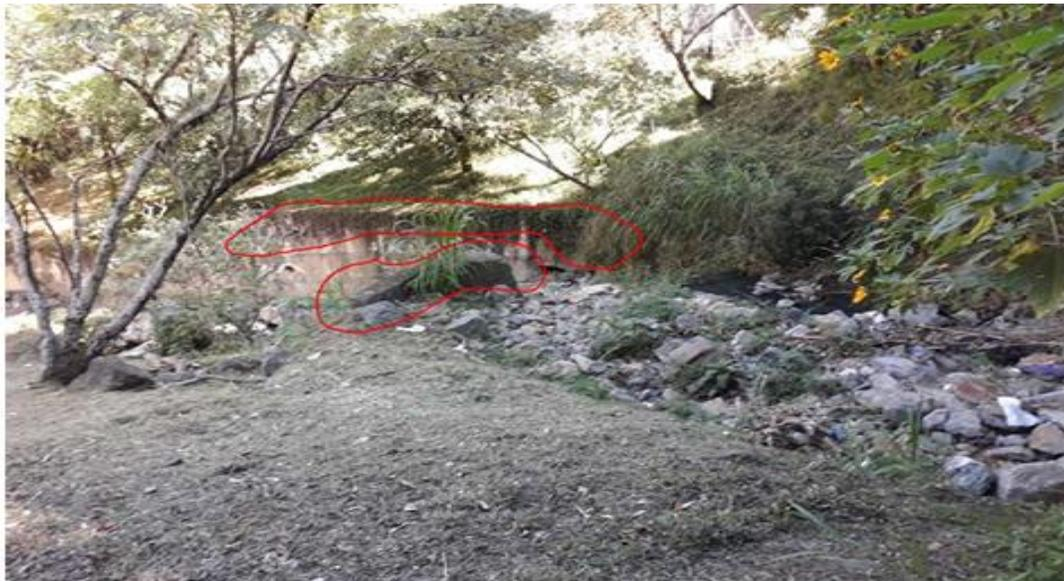
En estas imágenes, se puede evidenciar que los fragmentos y el muro que protegen el talud de la margen derecha de la quebrada en este punto, eran estructuras existentes. **Incluso algunas de las estructuras que sirvieron como soporte de la cimbra del puente no fueron demolidas en su totalidad por petición de la interventoría, ya que ayudan a proteger los estribos y demás estructuras.**
