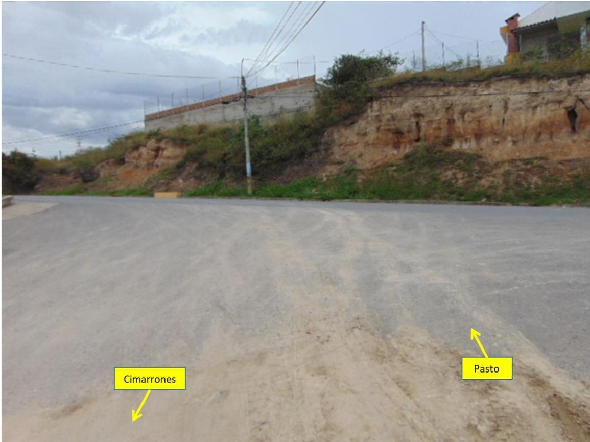
**FOTOGRAFÍA No. 7 PANORÁMICA:** En esta fotografía tomada por el equipo de IRS Vial en sentido Cimarrones - Pasto a la altura del km 34 + 200 m, se aprecian las características generales de la vía, en la cual no se encuentra demarcación horizontal o señalización vertical; en este sentido se desplazaba el vehículo No. 2 (Motocicleta).
