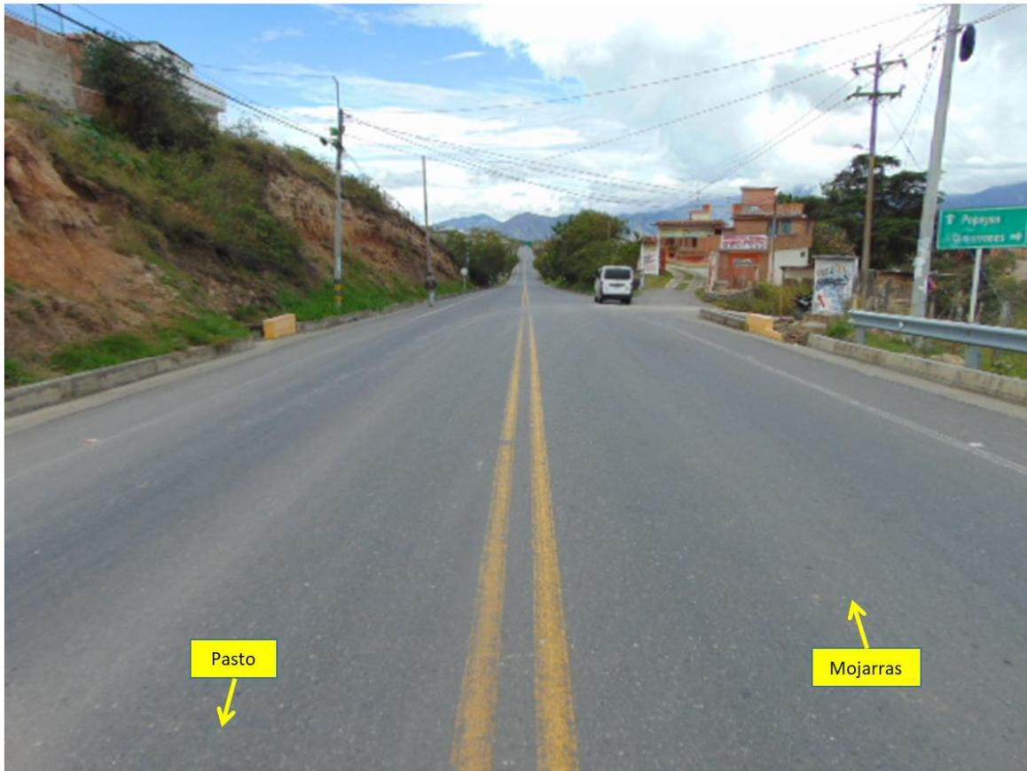
**FOTOGRAFÍA No. 5 PANORÁMICA:** En esta fotografía tomada por el equipo de IRS Vial en sentido Pasto – Mojarras a la altura del km 34 + 200 m, se aprecian las características generales de la vía, en la cual se encuentra demarcación horizontal de línea amarilla doble continua y líneas de borde, con señalización vertical SI-05 “Información previa de destino”; en este sentido se desplazaba el vehículo No. 1 (Camioneta).
