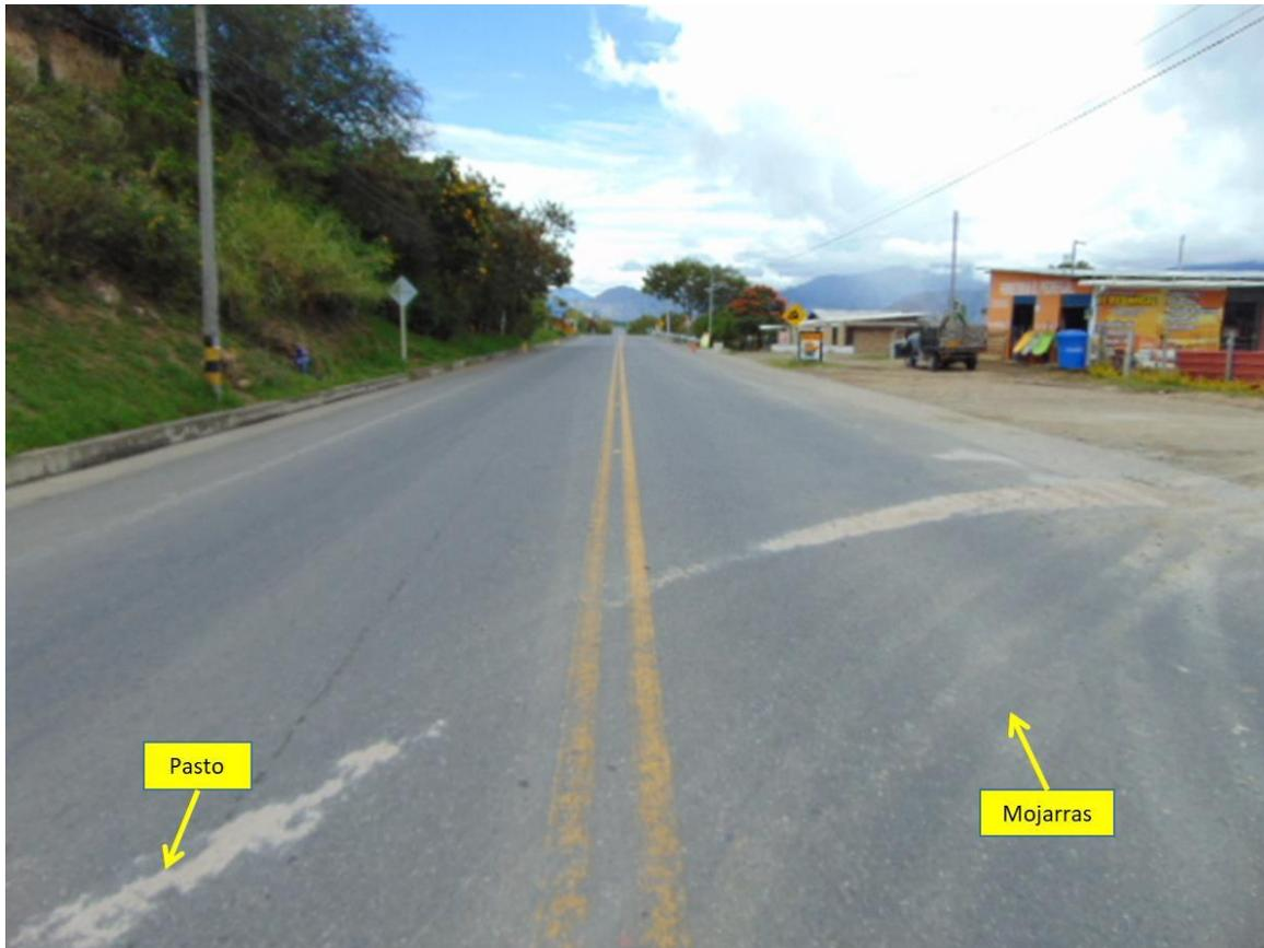
**FOTOGRAFÍA No. 1 PANORÁMICA:** En esta fotografía tomada por el equipo de IRS Vial en sentido Pasto – Mojarras a la altura del km 34, se aprecian las características generales de la vía, en la cual se encuentra demarcación horizontal de línea amarilla doble continua y líneas de borde, sin señalización vertical; en este sentido se desplazaba el vehículo No. 1 (Camioneta).
