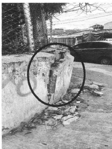
Foto 1. Ruptura del muro sobre la carrera 10
