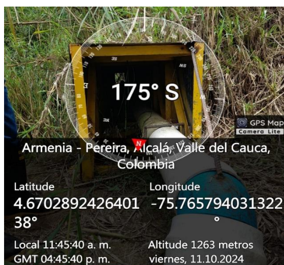
Fotos No 1 y 2: Ductos de entrada de agua a la Planta de tratamiento, con soporte al aire.
