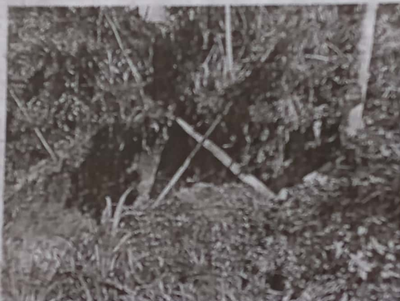
Tubería de acueducto en riesgo de colapso
