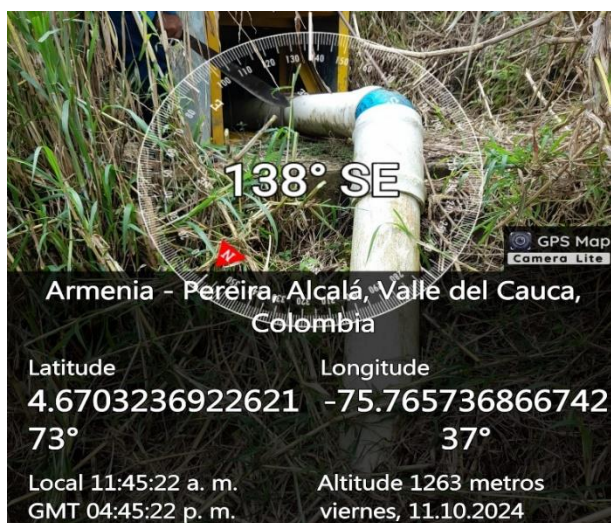
Fotos No 1 y 2: Ductos de entrada de agua a la Planta de tratamiento, con soporte al aire.
