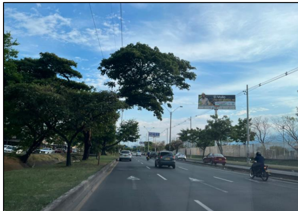
Autopista Sur oriental entre carrera 34 y 37, demarcación vial de tipo línea de borde, divisoria de carriles y flechas de sentido vial en buen estado.
