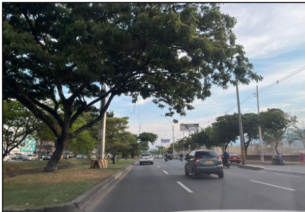
Autopista Sur oriental entre carrera 32 y Carrera 34, demarcación vial de tipo línea de borde y divisoria de carriles, en buen estado.
