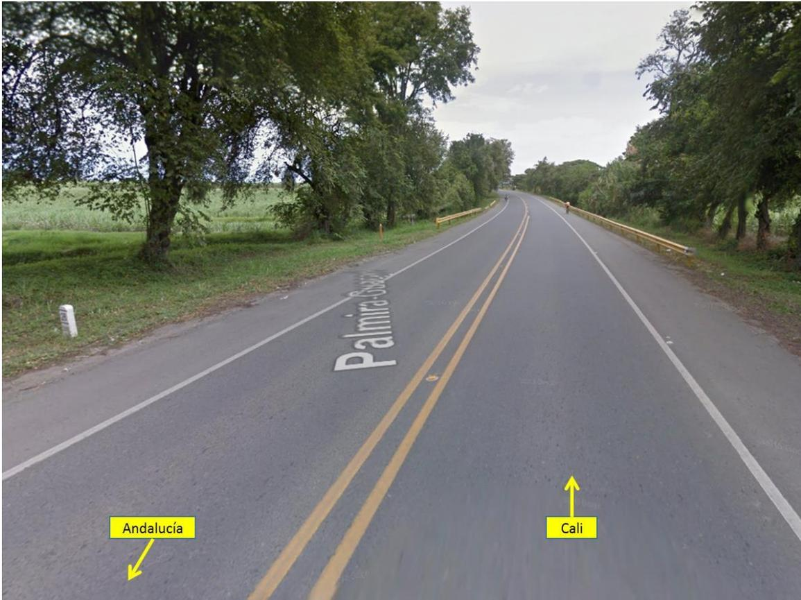
**FOTOGRAFÍA No. 4 PANORÁMICA:** En esta fotografía tomada en sentido Andalucía – Cali a la altura del km 26, se aprecian las características generales de la vía, en la cual se encuentra demarcación horizontal de línea doble continua y líneas de borde, con señalización vertical SI-04 “Poste de referencia”; en este sentido se desplazaban los vehículos No. 2 (Camioneta) y No. 3 (Buseta).
