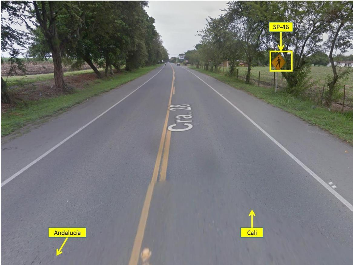
**FOTOGRAFÍA No. 5 PANORÁMICA:** En esta fotografía tomada en sentido Andalucía – Cali a la altura del km 25 + 950, se aprecian las características generales de la vía, en la cual se encuentra demarcación horizontal de línea doble continua y líneas de borde, con señalización vertical SP-46 “Peatones en la vía”; en este sentido se desplazaban los vehículos No. 2 (Camioneta) y No. 3 (Buseta).
