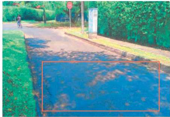
Figura 5: señal vertical de pare (SR-01) y reductor de velocidad no reglamentario
