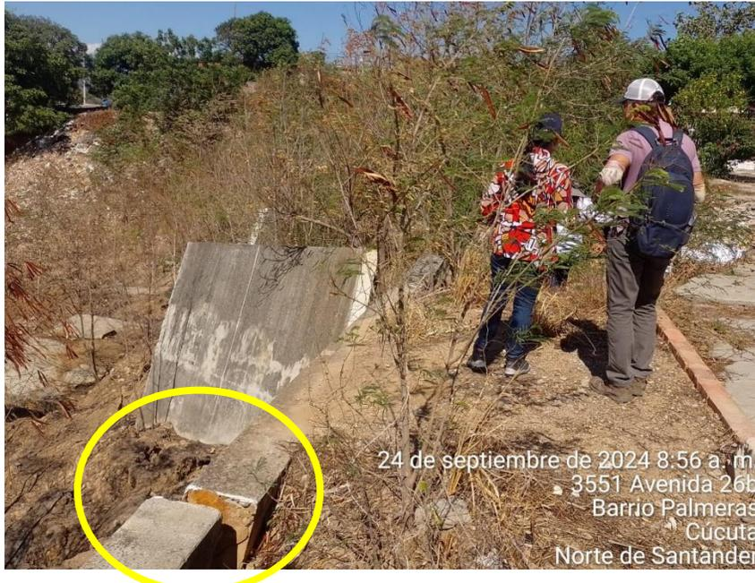
Se identifico en las placas que continuan en su posición y que no han sido desplazadas que ya existe separación en las juntas y dan indicio de ya encontrarse en proceso de desplazamiento.
