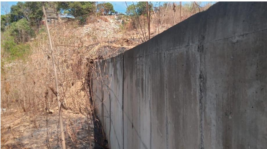
Se identifica el muro tipo 2 – no se presenta evidencia física de deslizamiento no se identifican grietas en la estructura.
