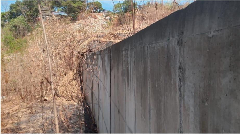
Se identifica el muro tipo 2 – no se presenta evidencia física de deslizamiento no se identifica grieta en la estructura.
