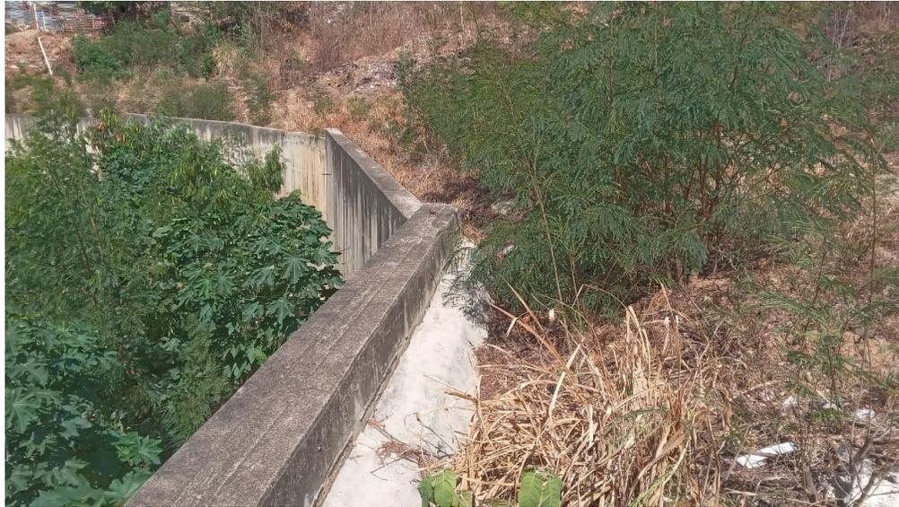
Se evidencia que para la zona del muro 1 localizado a borde de la quebrada, no llegó el incendio provocado en la parte alta, y sus estructuras no evidencian daño.
