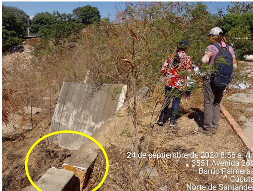
Se identifico en las placas que continuan en su posición y que no han sido desplazadas que ya existe separación en las juntas y dan indicio de ya encontrarse en proceso de desplazamiento.
