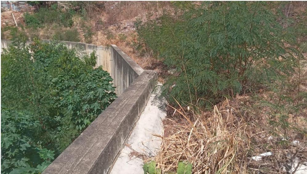
Se evidencia que para la zona del muro 1 localizado a borde de la quebrada, no llegó el incendio provocado en la parte alta, y sus estructuras no evidencian daño. Se identifica colmatación por falta de mantenimiento.
