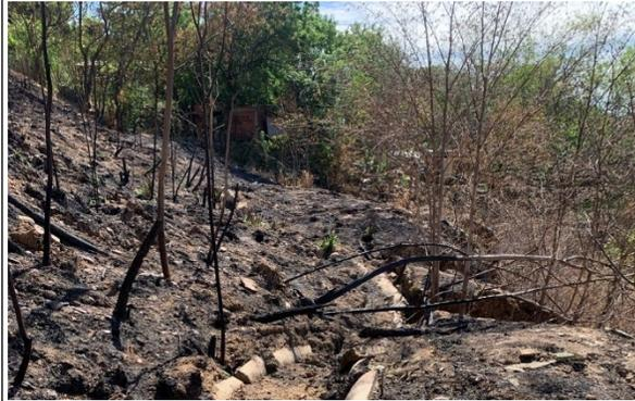
Estado de los Canales de drenajes secundario No. 2 y 3, se evidencia que el deslizamiento desplazo y separo las placas del canal.
