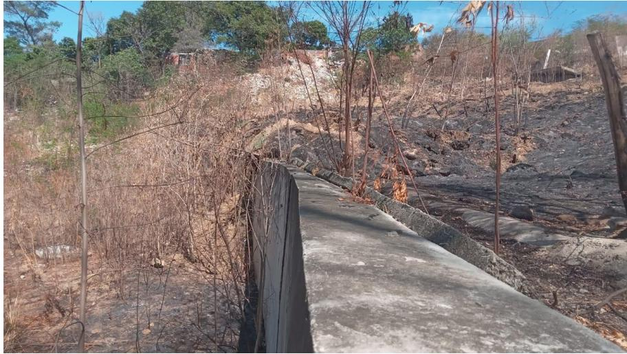
Estado del canal de drenaje secundario No. 4 construido en la corona del muro tipo 2, el cual, se evidencia que se encuentra levantado sobre el nivel de la corona del muro.
