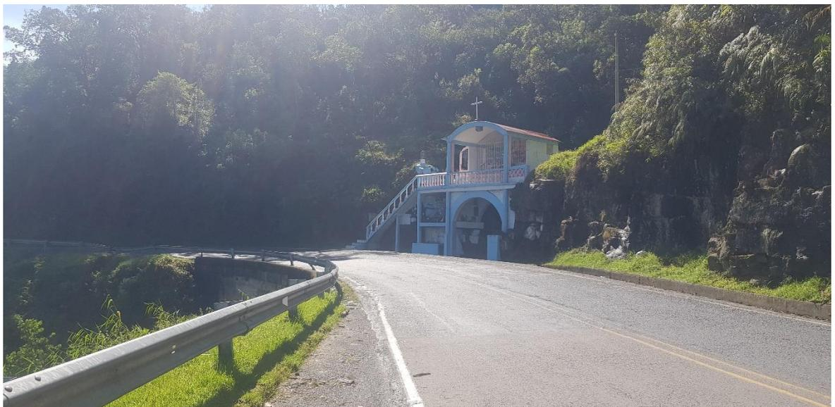
EN LA FOTA SE VE CLARAMENTE EL PROTECTOR VIAL LATERAL METALICO, QUE EVITA QUE UN VEHICULO SE SALGA DE LA CAPA DE RODADURA Y CAIGA AL PRECIPICIO, EN ESTE SECTOR SI HAY BERMA.
