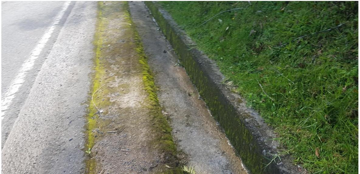
FOTO DONDE SE NOTAN CLARAMENTE LOS COMPONENTES DE LA VIA COMO SON LA BERMA LA CUNETA Y EL BORDILLO.
