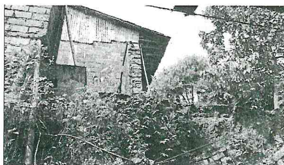
Muros apuntalados con guadua con riesgo de desplome sobre la vivienda calle 11 No. 5-10
