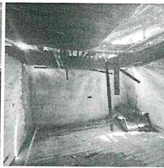
Colapso parcial de cielo raso y cubierta
