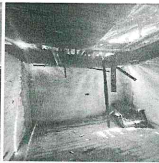
Colapso parcial de cielo raso y cubierta
