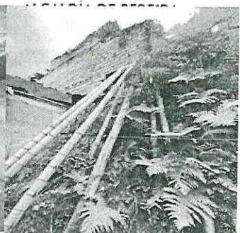
Apuntalamiento en extremo de baño de 2 piso para evitar colapso
