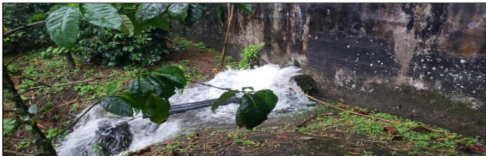
Figura 16. Ruptura de la antigua canal de conducción de la Hidroeléctrica de Dosquebradas “Acequia”.
