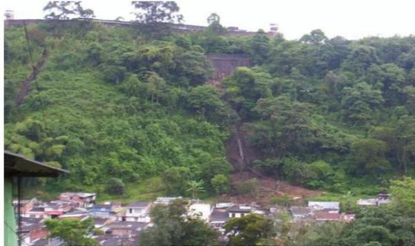
*Figura 1. Deslizamiento procedente desde una altura de cerca de 50 metros con respecto al sector de las viviendas del sector de las manzana G y 8 del barrio La Esneda en fecha de diciembre 7 de 2011*
