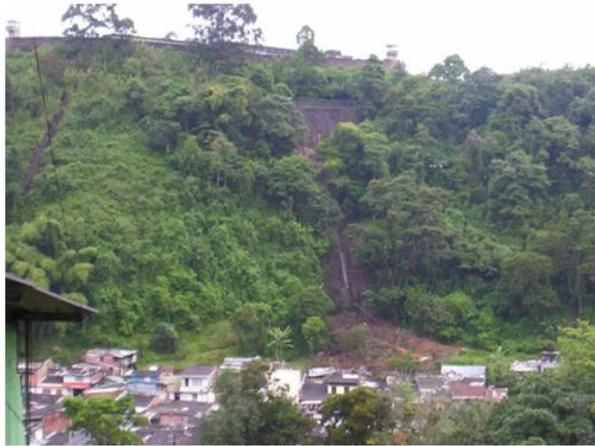
*Figura 1. Deslizamiento procedente desde una altura de cerca de 50 metros con respecto al sector de las viviendas del sector de las manzana G y 8 del barrio La Esneda en fecha de diciembre 7 de 2011*
