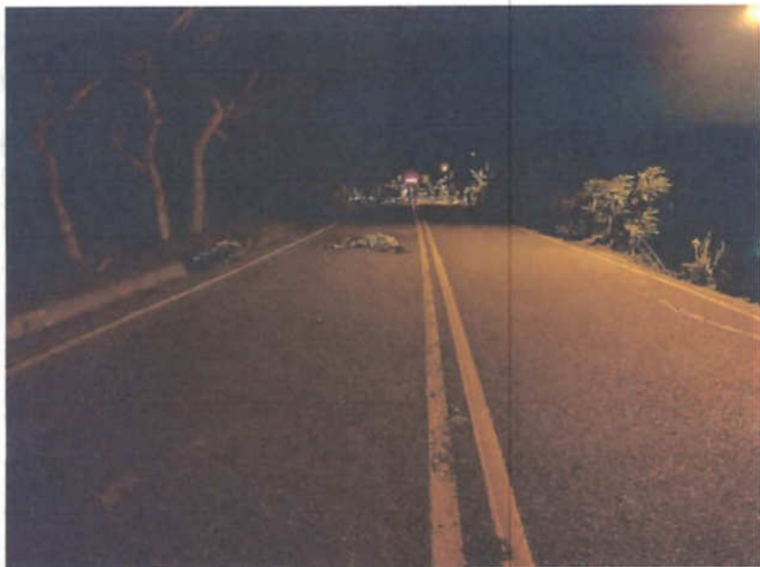
IMAGEN No.4. IMG_20211101_213310. PLANO GENERAL: FOTOGRAFÍA TOMADA SENTIDO NECOCLÍ - TURBO, DONDE SE OBSERVAN LAS CARACTERÍSTICAS GENERALES DE LA VÍA UNA CALZADA CON GEOMETRÍA RECTA, CONFORMADA POR DOS CARRILES UTILIZADOS EN DOBLE SENTIDO DE AVANCE VEHICULAR, DISEÑADA EN MATERIAL ASFALTO EN ESTADO BUENO Y SECO, DEMARCADA CON LÍNEAS DE BORDE DE PAVIMENTO DE COLOR BLANCO Y DOBLE LÍNEA CENTRAL AMARILLA CONTINUA, EN ESTE LUGAR HAY PRESENCIA DE ILUMINACIÓN ARTIFICIAL EN BUEN ESTADO DE CONSERVACIÓN Y SU ESTADO DE VISIBILIDAD ES BUENO Y NO SE ENCUENTRA INTERRUMPIDO.
