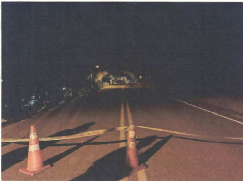
IMAGEN No.1. IMG_20211101_212832. PLANO GENERAL: FOTOGRAFÍA TOMADA SENTIDO TURBO - NECOCLÍ, DONDE SE OBSERVAN LAS CARACTERÍSTICAS GENERALES DE LA VÍA UNA CALZADA CON GEOMETRÍA RECTA, CONFORMADA POR DOS CARRILES UTILIZADOS EN DOBLE SENTIDO DE AVANCE VEHICULAR, DISEÑADA EN MATERIAL ASFALTO EN ESTADO BUENO Y SECO, DEMARCADA CON LÍNEAS DE BORDE DE PAVIMENTO DE COLOR BLANCO Y DOBLE LÍNEA CENTRAL AMARILLA CONTINUA, EN ESTE LUGAR HAY PRESENCIA DE ILUMINACIÓN ARTIFICIAL EN BUEN ESTADO DE CONSERVACIÓN Y SU ESTADO DE VISIBILIDAD ES BUENO Y NO SE ENCUENTRA INTERRUMPIDO.
