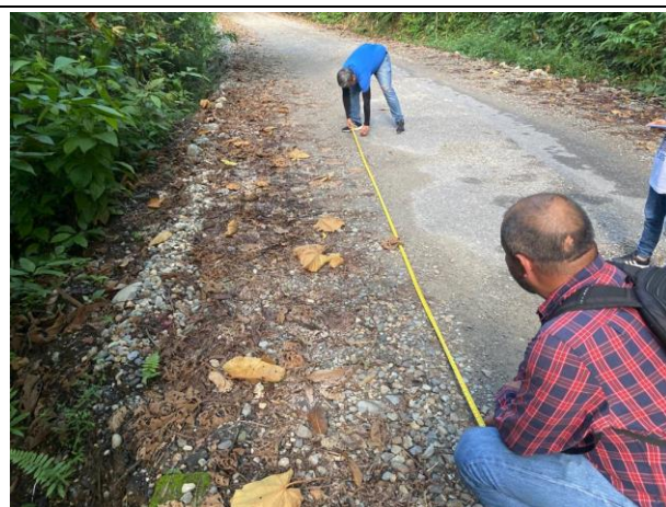
Figura 2. K1+480 a K1+495 no han levantado la carpeta asfáltica existente en mal estado
