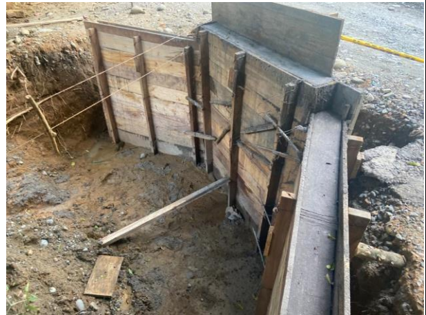
Figura 16. Se evidencia avance en la construcción del box culvert
