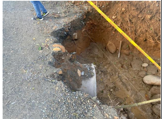
Figura 14. Obra pendiente solo se evidencia instalado el tubo.
