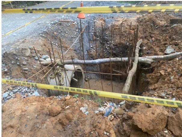
Figura 15. Instalado tubo, parrilla y acero de alcantarilla.
