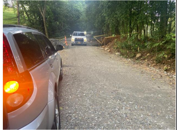
Figura 12. Alcantarilla ubicada en la abscisa K2+0,81 se evidencia como los carros pasan cerca al borde de la alcantarilla.
