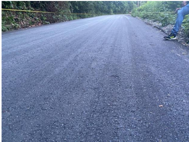
Figura 7. inspección visual se identifica desgaste superficial, pérdida del agregado
