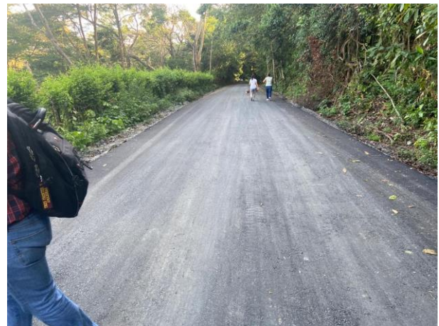
Figura 6. K1+898 a K2+012,80 (114,80 ml) instalada mezcla asfáltica densa en caliente MDC-19 tipo invias en ambos costados
