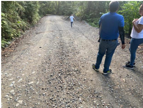
Figura 3. K1+495 a K1+898 (403 ml) según lo informado por la interventoría tiene instalado material de relleno, subbase granular, base granular.
