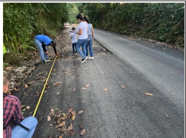
Figura 10. K2+012,80 a K2+049,30 (36,80 ml) instalada mezcla asfáltica densa en caliente MDC-19 tipo invias costado derecho según abcisado.
