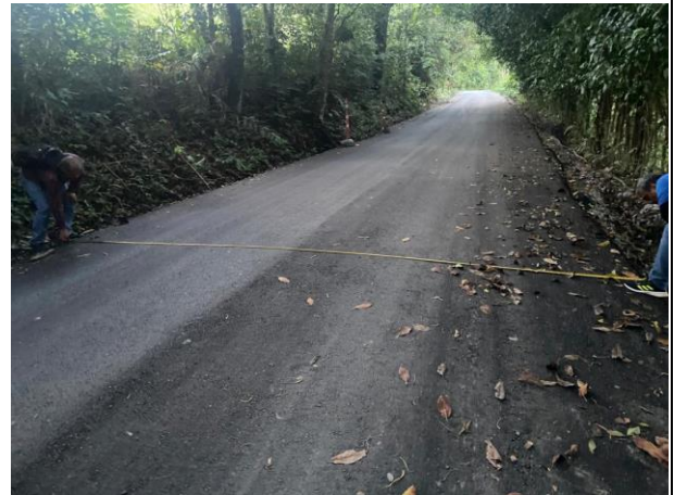
Figura 8. inspección visual se identifica ahuellamiento, ondulación
