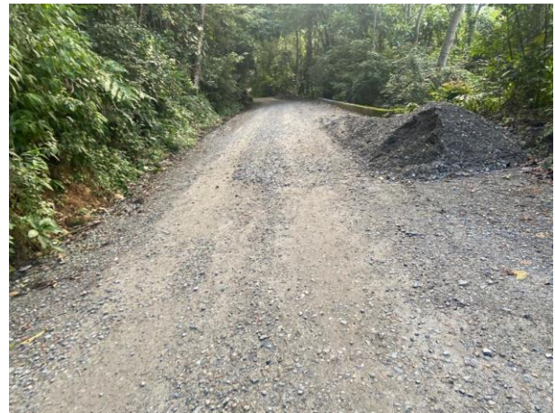
Figura 4. K1+495 a K1+898 (403 ml) según lo informado por la interventoría tiene instalado material de relleno, subbase granular, base granular, se evidencia material sobre la vía para cereo de ultima capa granular.
