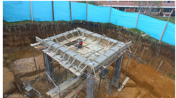
Ítem 4.2Item 4.2 -fundida vigas de enrase zona de lavado
