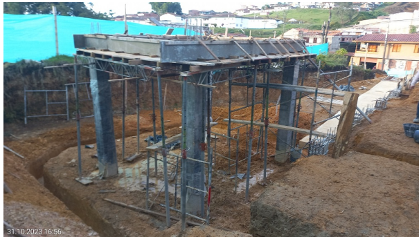
Ítem 4.2 - Instalación de formaleta para fundida vigas de enrase zona de lavado
