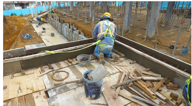
Ítem 4.2 - Instalación de formaleta y ajuste de aceros para fundida vigas de enrasedado zona de lavado
