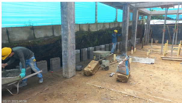
Ítem 6.2 - Instalación de muro en bloque de concreto 15x20x40 cm
