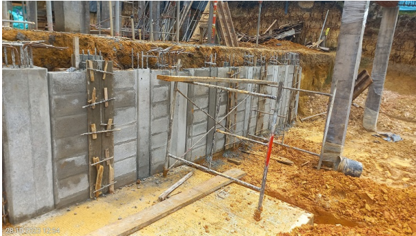
Fundida de concreto para columnetas rampa
