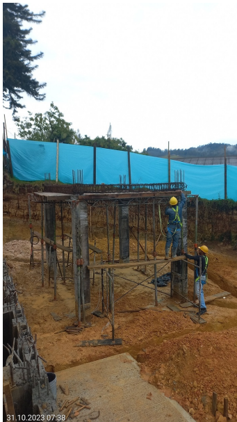
Ítem 4.2 - Instalación de formaleta inferior para fundida vigas de enrasedado zona de lavado
