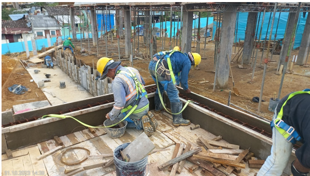
Area Seguridad Industrial - Uso de los equipos para la ejecución de trabajos en altura Trabajos en
