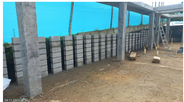
Ítem 6.2 - Instalación de muro en bloque de concreto 15x20x40 cm
