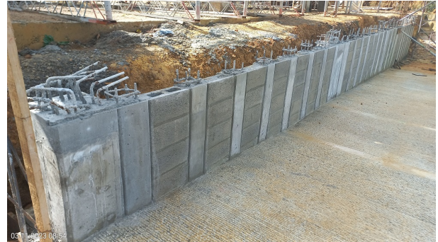
Fundida de concreto para columnetas rampa
