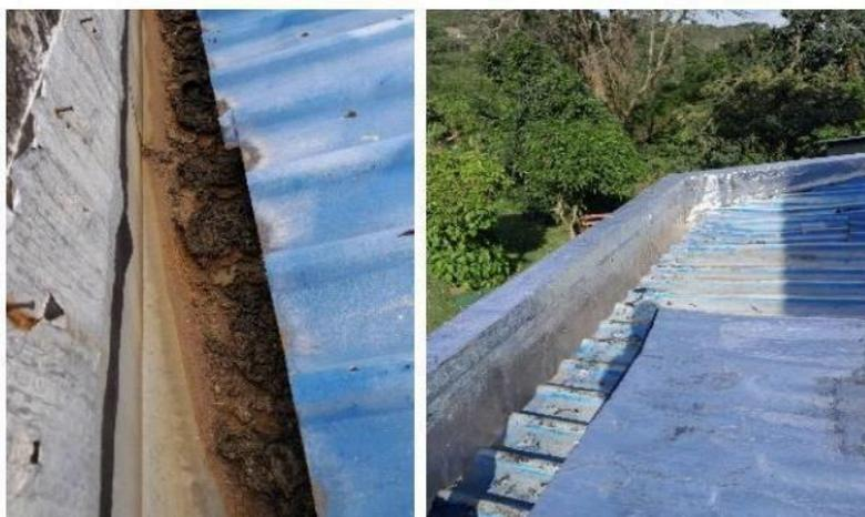
b. SOLAPA CON CINTA ADHESIVA EN MUROS Y CANALES DE AREAS ADYACENTES (MANDELA Y DEPOSITO) ANCHO 1,30 MTS
