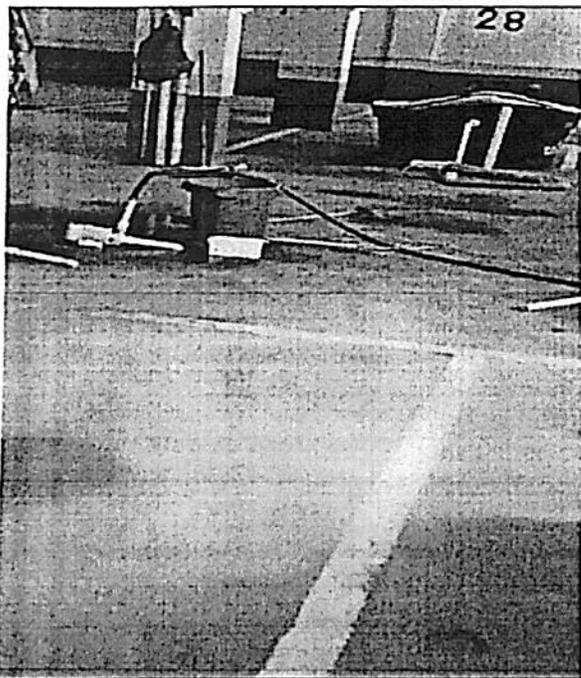
Como trabajo a realizar se procede a drenar el agua que se encuentran en las cajas utilizando una motobomba de 1HP por el termino de 6 horas y 40 minutos, trabajo realizado en el termino de dos dias, esto logra evidenciar que el piso inicia su procedo de secado como se puede evidenciar en los registros anteriores.
