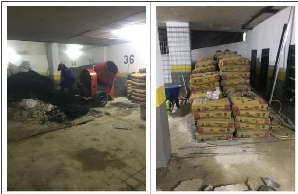
Foto 4 – Preparación de Concreto en Obra
