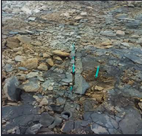
Tubería Conduit Eléctrica trabajando como “drenaje” Imágenes 18 y 19
