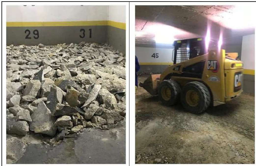
Foto 2 – Demolición y retiro de escombros
