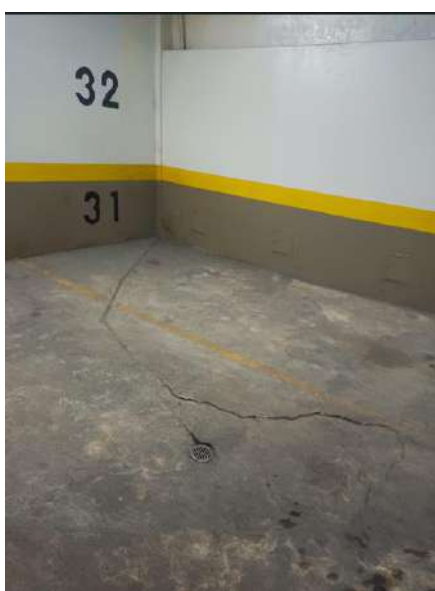
Daños en la placa de rodadura (imágenes 2-7)
