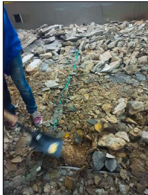
Tubería Conduit Eléctrica trabajando como “drenaje” Imágenes 18 y 19
