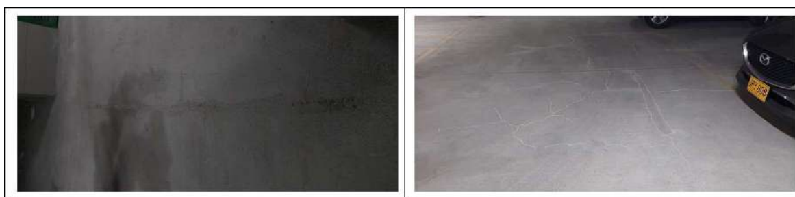
Foto 10 – Fisuras reparadas
