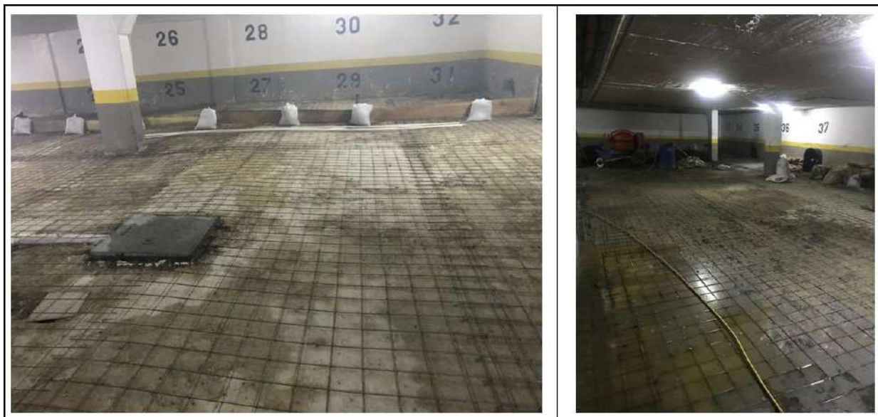
Foto 3 – Alistado de piso y colocación de malla
