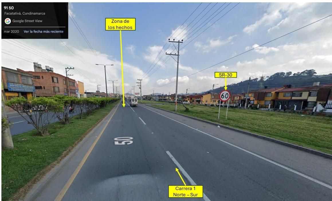
**Fotografía No. 1 Panorámica:** En esta fotografía sustraída de Google Street View (marzo 2020) en sentido norte – sur en la carrera 1 frente al No. 8-16, se aprecian las características generales de la vía, en la cual se encuentra demarcación horizontal de línea blanca segmentada y líneas de borde, con señalización vertical SR-30 (Velocidad máxima 60 km/h); en este sentido se desplazaba el vehículo No. 1 (Camioneta).
