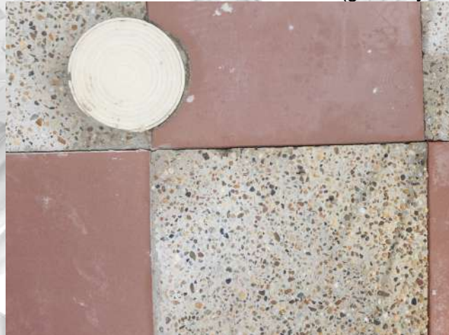
Foto 5: Dilatación en unión de materiales (granito y tableta)
