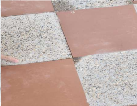
Foto 9: Dilatación en unión de materiales (granito y tableta)
