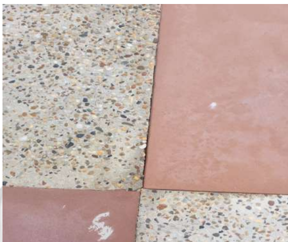
Foto 8: Dilatación en unión de materiales (granito y tableta)
