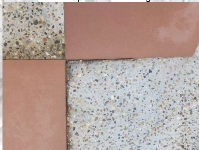
Foto 7: Dilatación en unión de materiales (granito y tableta)
