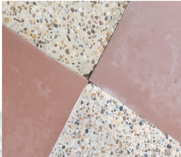
Foto 4: Dilatación en unión de materiales (granito y tableta)
