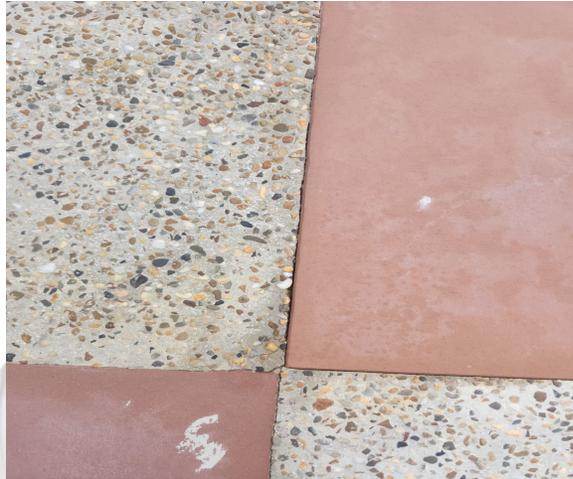
Foto 8: Dilatación en unión de materiales (granito y tableta)
