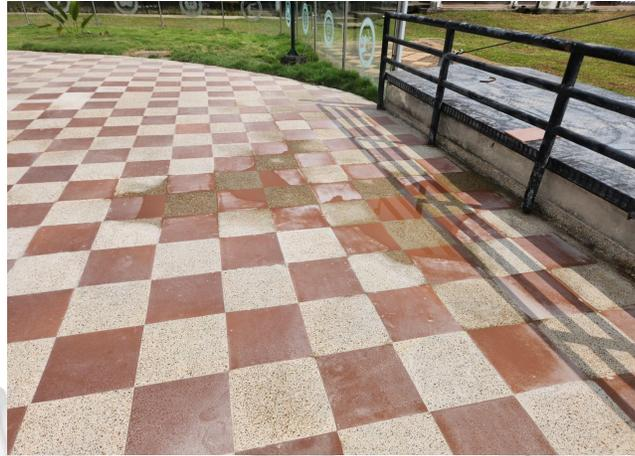
Foto 15: Empozamiento de agua debido a falta de nivelación en piso de piscina
