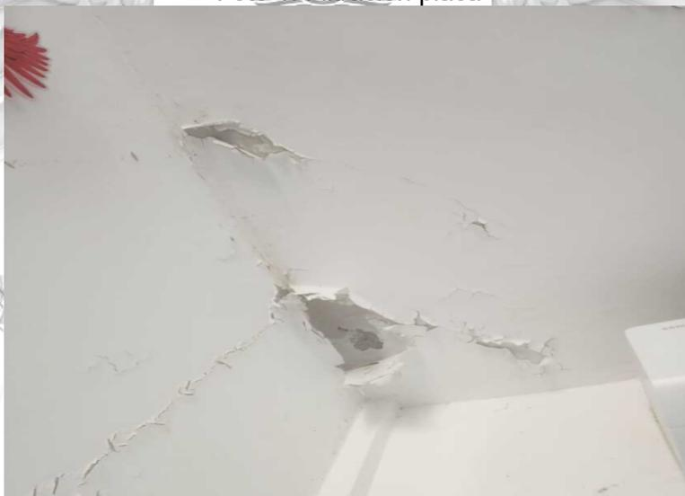
Foto 2: Levantamiento de pintura por humedad
