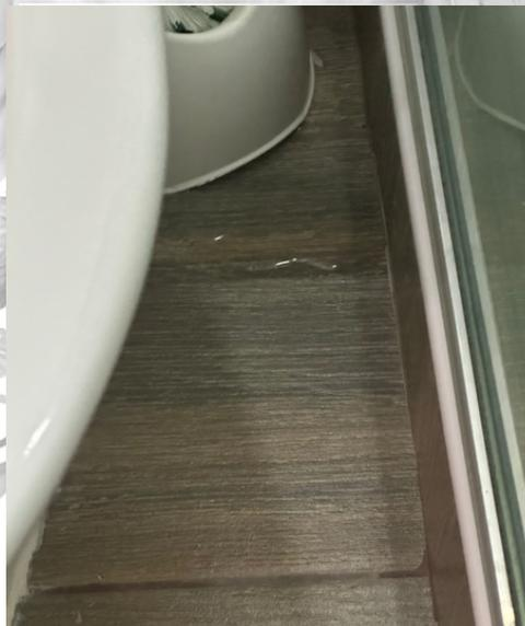
Foto 2: Filtración de agua en división de baño
