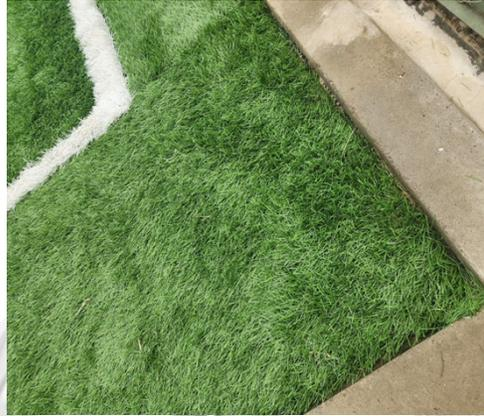
Foto 7: ausencia de caucho molido y arena en cancha sintética
