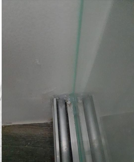
Foto 1: Filtración de agua en división de baño
