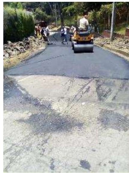
Instalación de mezcla asfáltica en el Corregimiento el Saladito – vía a San Miguel.
