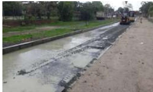
En la Carrera 3 entre Calles 77 y 73A, se realizó excavación mecánica en área de 320 M<sup>2</sup>, con una estructura de 70 cm, presentando un avance a la fecha del 19%.
