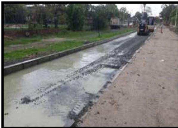
En la Carrera 3 entre Calles 77 y 73A, se realizó excavación mecánica en área de 320 M<sup>2</sup>, con una estructura de 70 cm, presentando un avance a la fecha del 19%.
