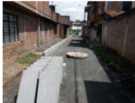
Se realizan las actividades en la carrera 33c entre calles 46a a la 45, en 721 m2 con una estructura de 45 cm, de las actividades referentes a instalación de bordillos y fundición de curvas para iniciar instalación de base, realizando las actividades con normalidad, presentando un avance entre el 43 al 48% a la fecha.
