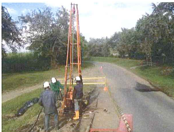
Trabajos de Perforación – campaña geotécnica
