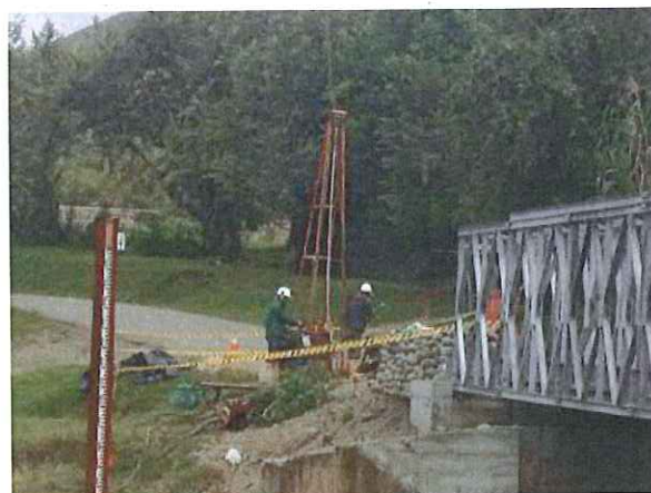
Trabajos de Perforación – Estribo Derecho
