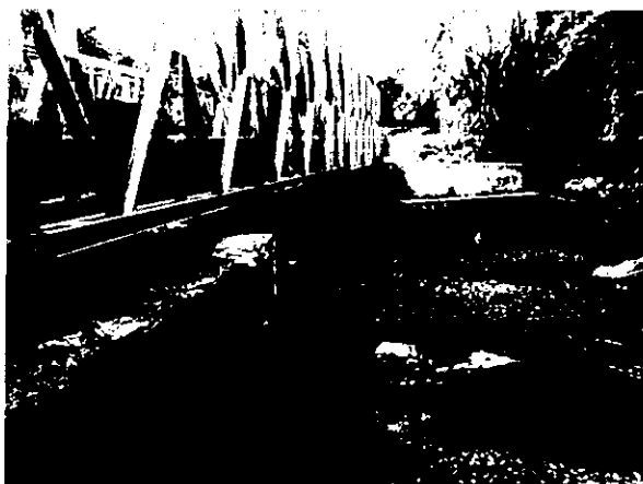
Imágenes de los estribos socavados por acción del agua – Puente El Jagual
