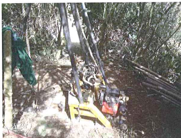
Trabajos de Sondeos – Maquina localizada en el sondeo #4
