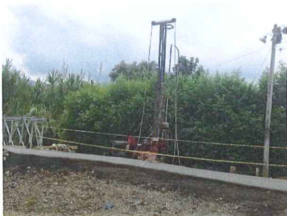
Trabajos de Perforación – Estribo Izquierdo
