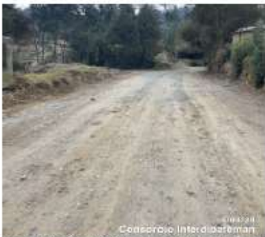
Imagen 17. Abscisa K0+320 a la K0+370, estado de la sub base granular previo a la suspensión de las actividades de obra
