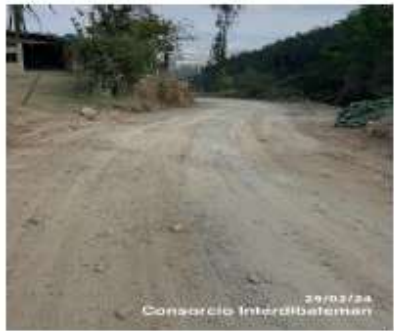
Imagen 11. Abscisa K0+290, estado de la sub base granular previo a la suspensión de las actividades de obra.
