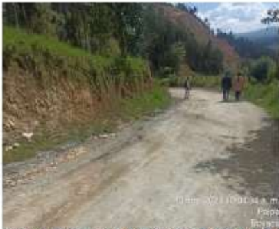
Imagen 4. Arrastre del material de la subrasante entre las abscisas K0+170 a K0+190, borde derecho
