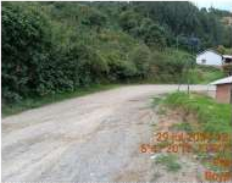
Imagen 5. Arrastre del material de la subrasante en la curva 8 entre las abscisas K0+370 a K0+320, costado derecho
