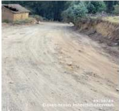
Imagen 5. Abscisa K0+230, estado sub base granular, previo a la suspensión de las actividades de obra.
