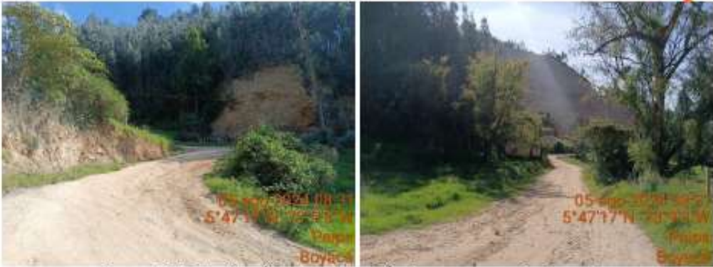
Imagen 1. Registro fotográfico de no disposición de persona y maquinaria en obra.
