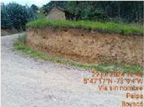
Imagen 2. Crecimiento de material vegetal por la exposición de la subrasante, entre las abscisas K0+160 a la K0+200 costado derecho.
