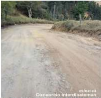
Imagen 9. Abscisa K0+235, estado de la sub base granular previo a la suspensión de las actividades de obra.
