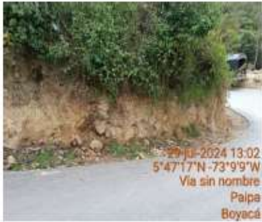
Imagen 27. Cuneta borde derecho de la K0+635 a la K0+670, costado derecho.
