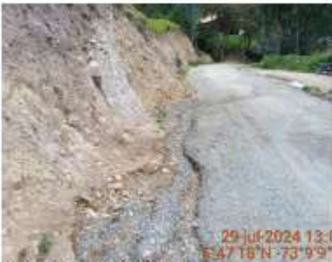
Imagen 5. Arrastre del material de la subrasante en la curva 8 entre las abscisas K0+370 a K0+320, costado derecho
