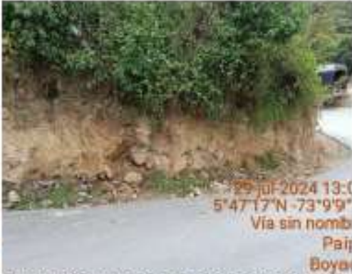
Imagen 9. Arrastre del material de la subrasante en la curva 12 entre las abscisas K0+540 a K0+490, costado derecho (zona donde el contratista no ejecuto la cuneta)
