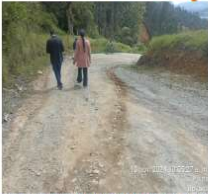
Imagen 10. Abscisa k0+235 al K0+270, estado actual sub base granular conforme a la visita del 13 de noviembre de 2024.
