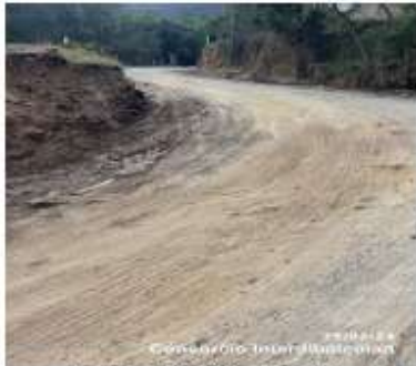
Imagen 7. Abscisa K0+235, estado de la sub base granular previo a la suspensión de las actividades de obra
