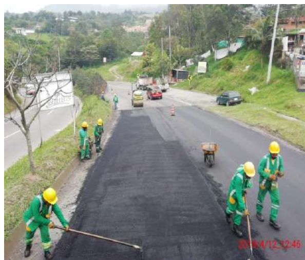
Fotografía 4. Renivelación hundimiento PR70+650 GB
