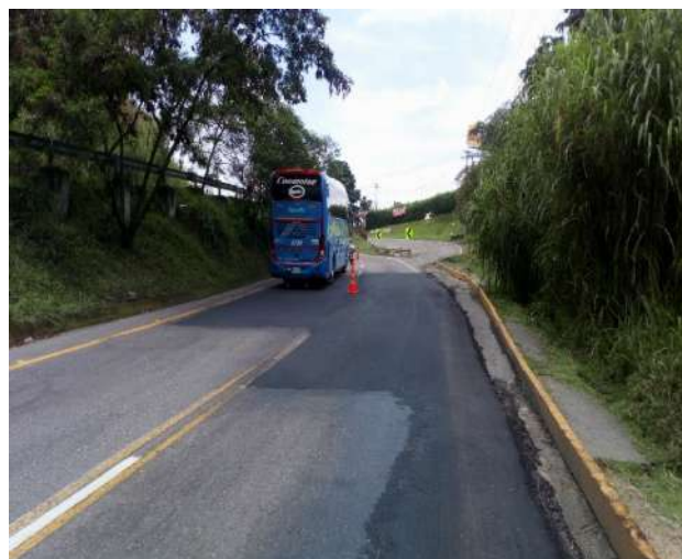
Fotografía 3. Renivelación hundimiento PR74+300 BG
