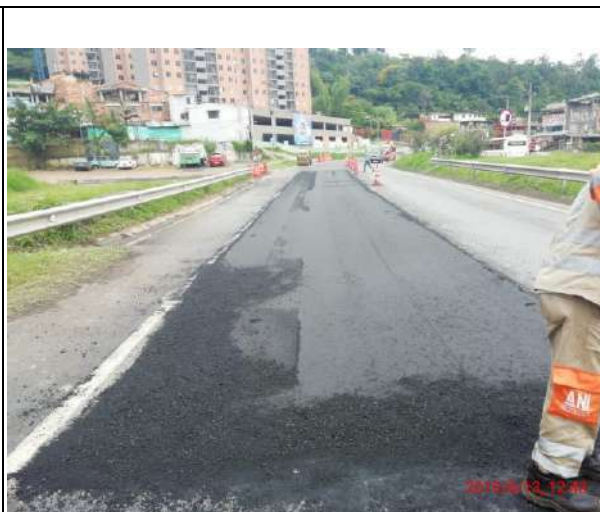
Fotografía 6. Actividades de mantenimiento; parcheo Segmento PR78+000 – 79+000 GB
