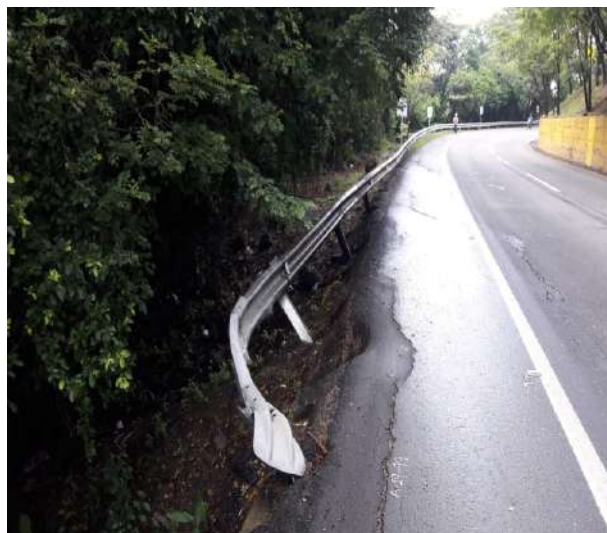
Fotografía 19. PR32+300 BG medición indicador E12 barreras con daños con una longitud de 30 m
