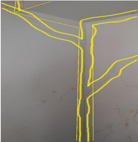
Fotos N° 54 y 55: Grietas y fracturas en muros, en diferentes sentidos, afectaciones en pisos y zocalos.
