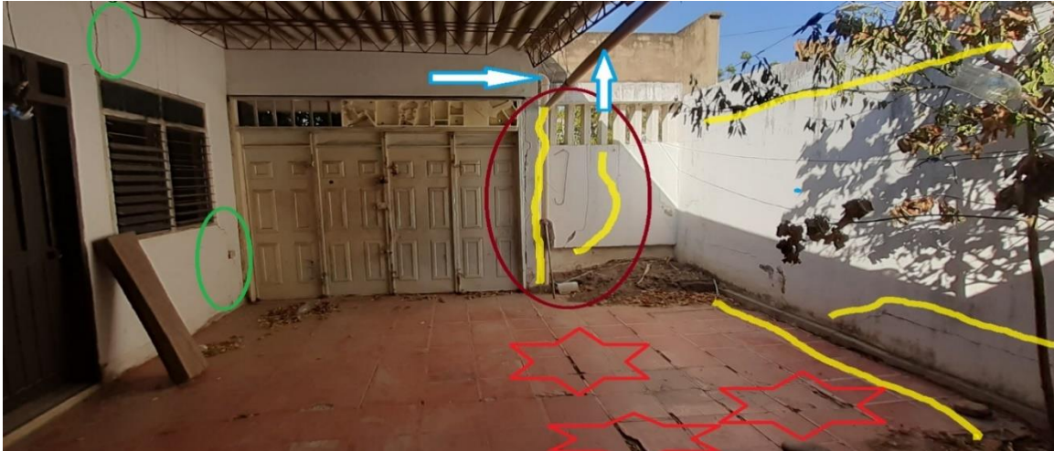
Foto N° 115: Vista interna del patio y garaje cubierto, estado actual, referencias de patologías, como: fisuras, grietas, fracturas de elementos estructurales y no estructurales, agrietamiento de pisos, presencia de humedades, entre otras.
