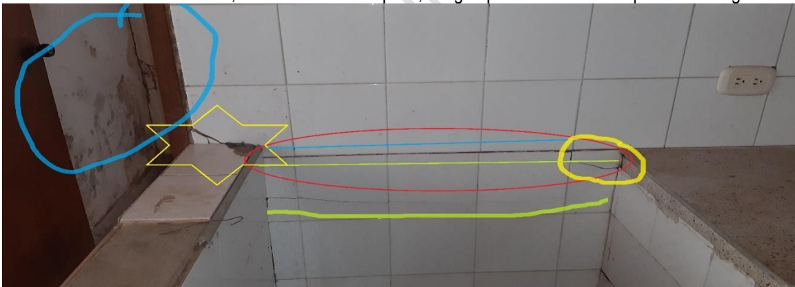
Foto N° 94: Muestras de grietas, roturas humedad y desprendimientos de enlucidos en muros con y sin revestimientos.
