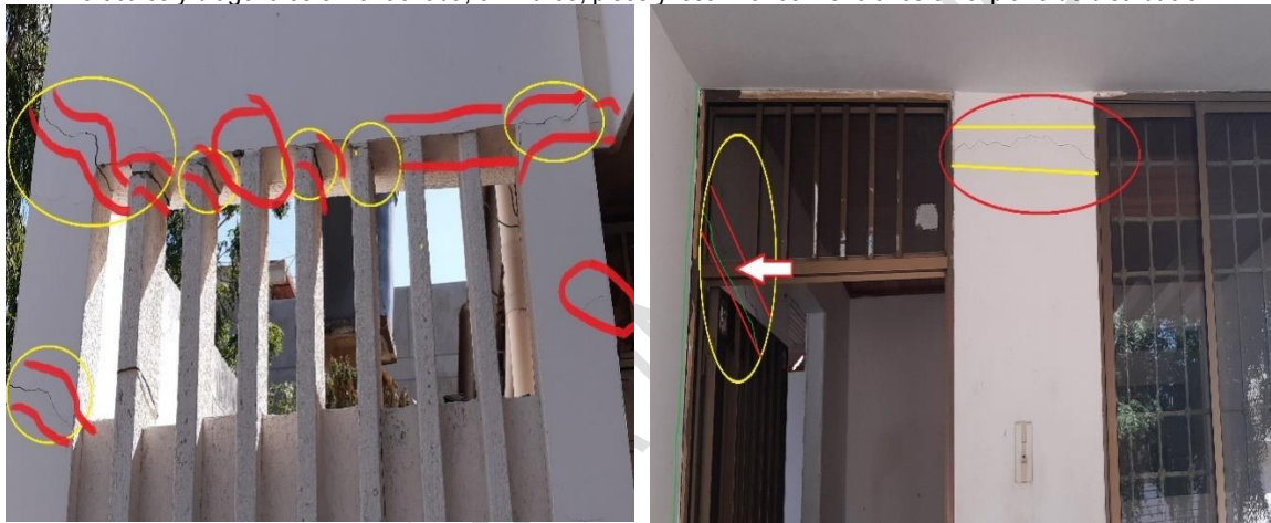
Foto N° 14: fractura completa de los elementos – Foto N° 15: grietas horizontales y verticales en muros.
