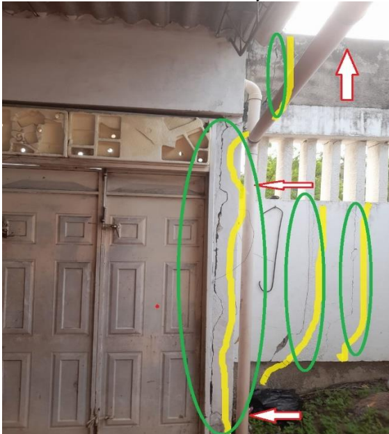
Foto N° 116: Fisuras y grietas verticales en muros. – Foto N° 117: Grieta diagonal en muro, presencia de humedad.
