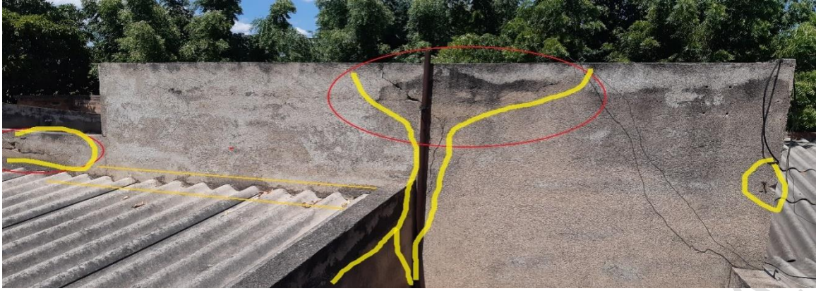
Fotos N° 28: Estado actual de cuchillas o culatas de soporte para cubierta en asbesto cemento, es necesario demoler completamente los muros de una altura de 2.20 mts en adelante para confinar y fundir viga perimetral.
