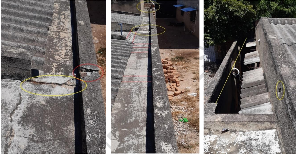
Fotos N° 29, 30 y 31: Grietas, fracturas y desprendimientos de enlucidos, evidencia de la falta de impermeabilizaciones, en pisos, losas y otros elementos.
