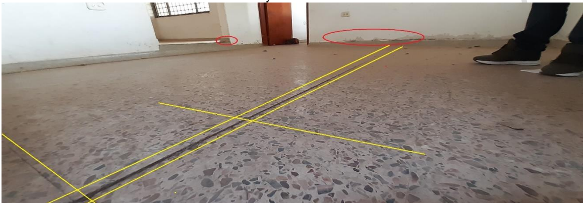
Fotos N° 44 y 45: Estado actual del piso en la vivienda, manifiesta desplazamiento, rotura y desprendimientos al igual que los zócalos, piso en baldosas de granito fundido y pulido, tipo Alfa, con zócalos en media caña en granito.
