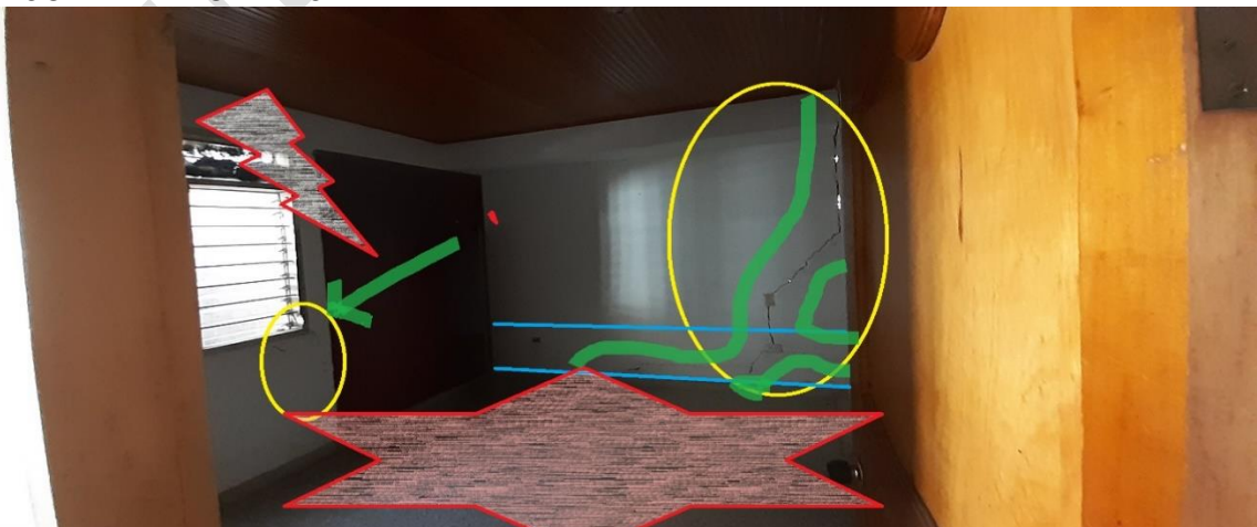
Foto N° 66: Fracturas en sentido vértical, espesor \leq 25\text{mm} , con desprendimientos de enlucidos y presencia de humedades y agentes biológicos.
