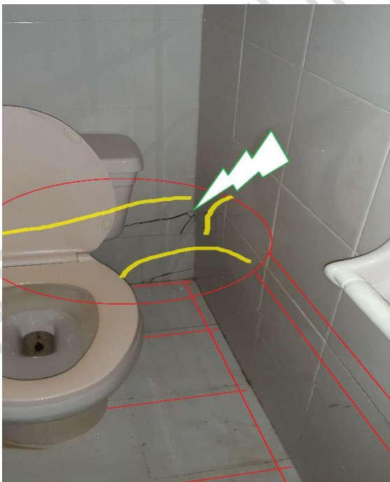
Fotos N° 74 y 75: Rotura completamente del muro afectando incidentalmente su recubrimiento, (enchape de cerámica), se logra apreciar el estado de la losa, manifestando grietas, humedades y descalcificación.
