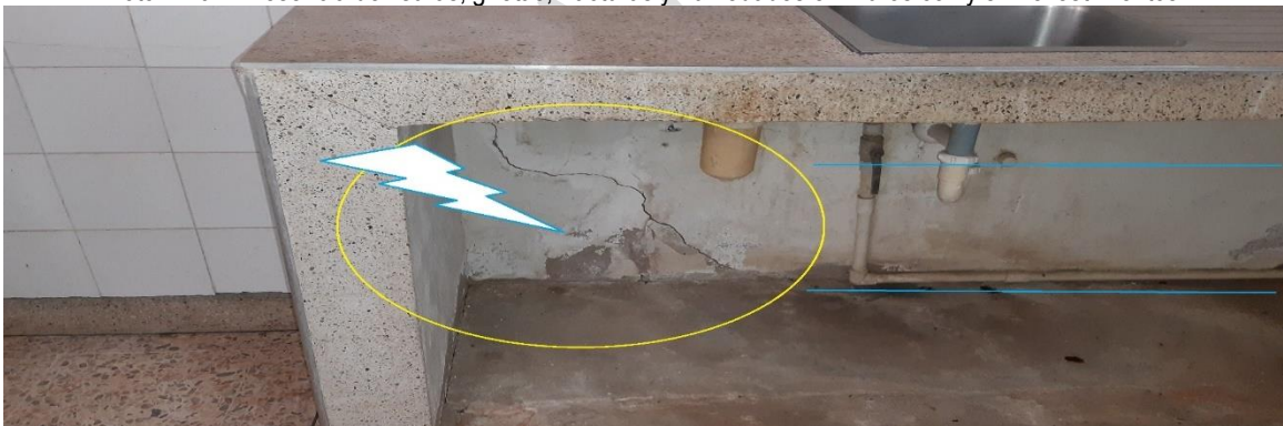
Foto N° 98: Presencia de fisuras, grietas, fracturas y humedades en muros con y sin revestimientos.
