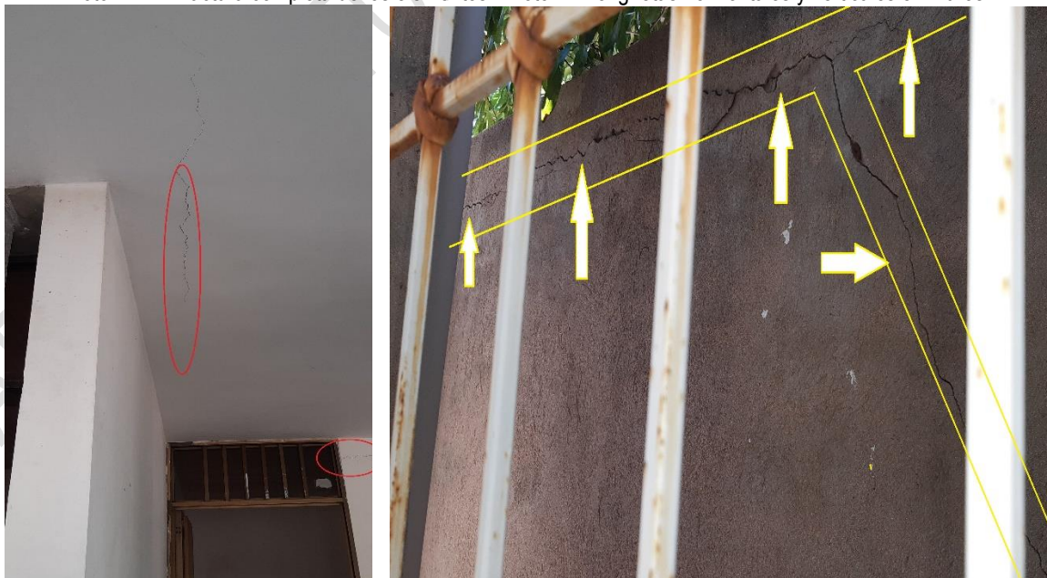
Foto N° 16: Grieta en losa, terraza ext. fachada estado (progresivo) - Foto N° 17: Muro de cerramiento con manifestaciones de grietas y fracturas en diversos sentidos.
