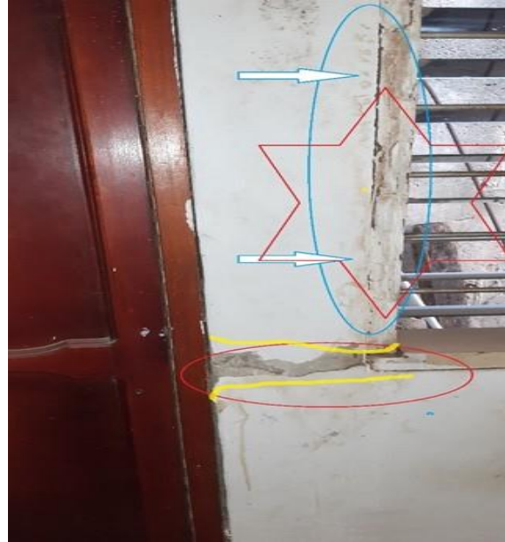
Fotos N° 83 y 84: Presencia de fisuras, grietas, fracturas y roturas de muros, pisos y zócalos, acompañadas de humedad, tanto en la mampostería como en la carpintería de madera, sumando los desprendimientos de enlucidos.
