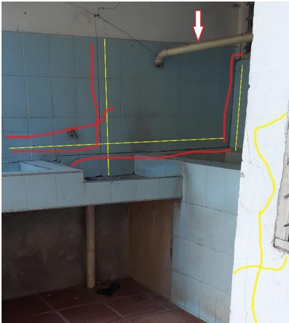
Foto N° 123: Evidentes grietas horizontales en el muro. - Foto N° 124: Agrietamiento de pisos, presencia de humedad
