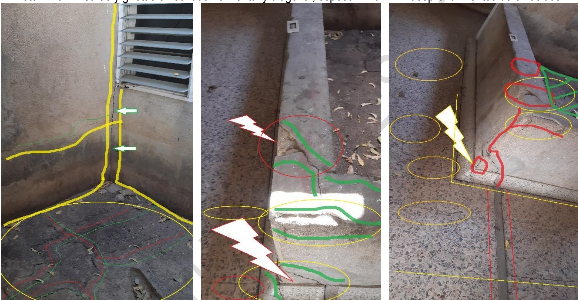
Foto N° 63, 64 y 65: Grietas presentes en plantillas de nivelación, en mortero. – Manifiesta fisuras en las juntas de pegan los pisos. – pisos tratados inadecuadamente, intervención realizada por el cliente, puesto que inicialmente tubo el proposito de hacer las reparaciones por su cuenta.
