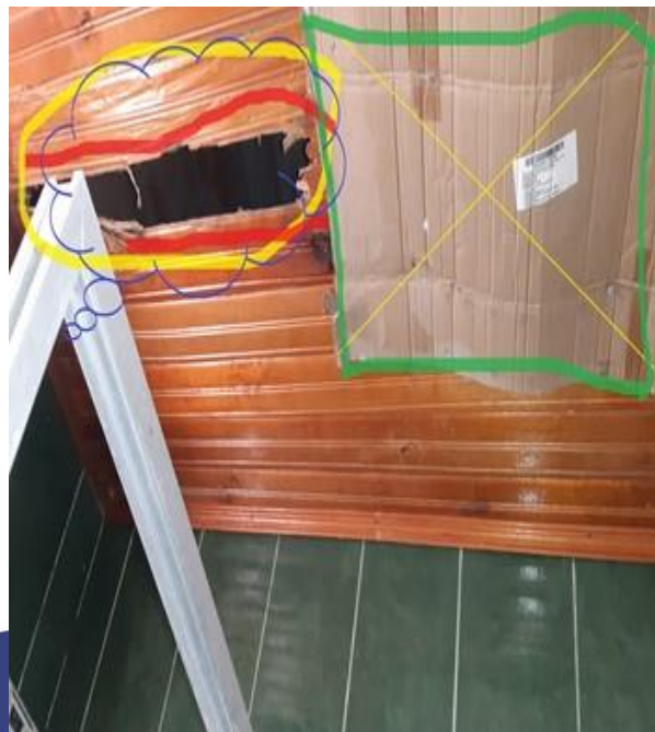
Fotos N° 86 y 87: Deterioro del enchape por fisuras y grietas, cielo raso afectado por la humedad y agentes patógenos.
