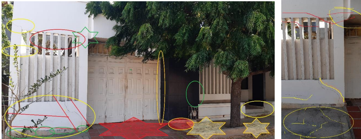
Fotos N° 12 y 13: Exposición de fisuras, grietas y rotura de los elementos, en diversos sentidos; horizontales, verticales y diagonales en la fachada, en muros, pisos y losa. Ver convenciones en el plano de distribución.
