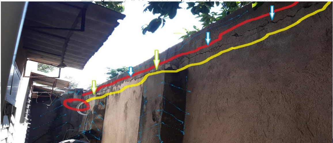
Foto N° 126: Muro lateral de la camara de aire, manifesta fisuras, grietas horizontales y humedades, altura de viga
