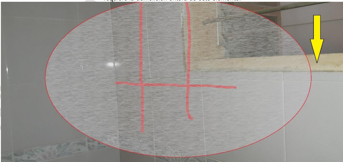
Foto N° 78: Rotura completamente del muro afectando incidentalmente su recubrimiento, (enchape de cerámica), en el caso de los vanos, es donde más se exponen estos casos, debido a la inexistencia de la viga perimetral de amarre.
