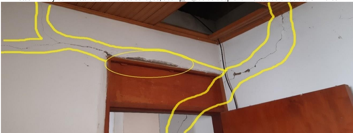
Fotos N° 51: Fracturas en diversos sentidos, acompañadas de desprendimientos de enlucidos en muros.
