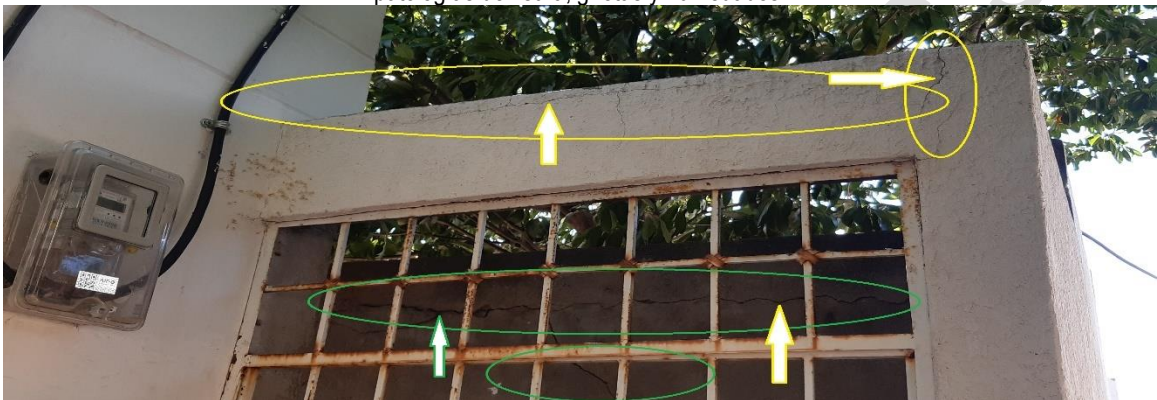
Foto N° 19: Muro de cerramiento con manifestaciones de grietas y fracturas en diversos sentidos.
