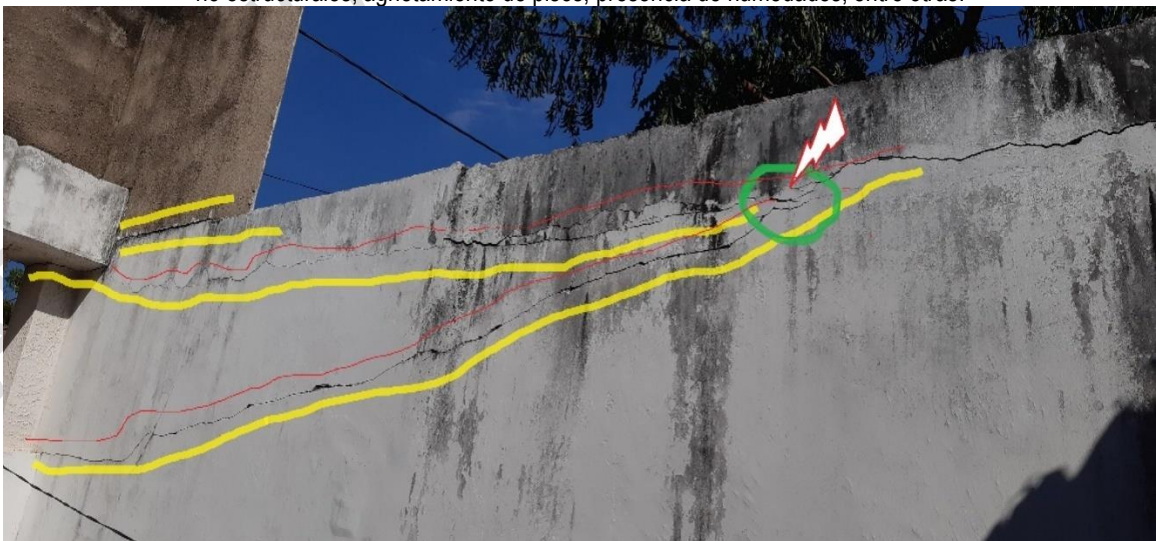
Foto N° 122: Muro lateral de cerramiento del patio, manifiesta fisuras, grietas horizontales y humedades, altura de viga
