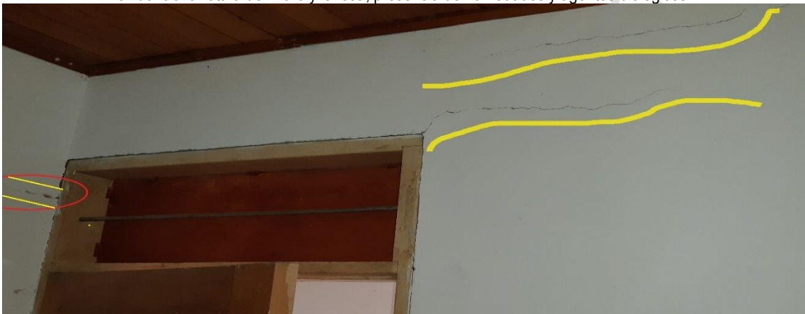
Foto N° 73: Fisuras y grietas horizontales, con desprendimientos de enlucidos y desplazamiento del muro.
