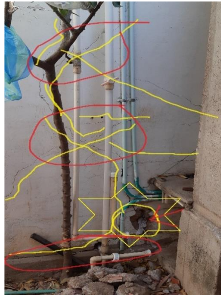
Foto N° 119: Evidentes grietas horizontales en la base del muro, asociado a esto la presencia de humedades y agentes biológicos. - , Foto N° 120: Muro con múltiples fisuras y grietas en diversos sentidos, estallado totalmente.
