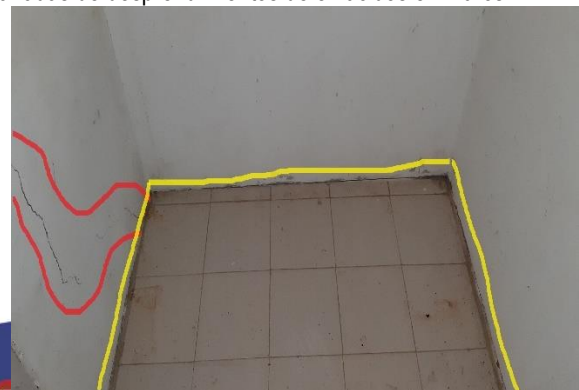
Fotos N° 52 y 53: Fracturas en los muros, en diversos sentidos, acompañadas de desprendimientos de enlucidos en muros, y pisos, (enchape de cerámica).
