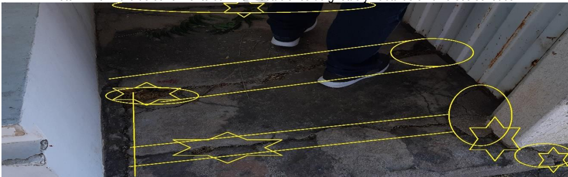
Foto N° 20: Piso en mortero totalmente fracturado, se requiere la demolición completa, estabilizar el terreno y posteriormente aplicar nueva plantilla, en este caso inicialmente estructural y despues la de nivelación.
