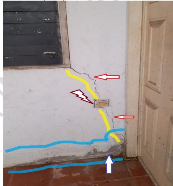
Foto N° 116: Fisuras y grietas verticales en muros. – Foto N° 117: Grieta diagonal en muro, presencia de humedad.
