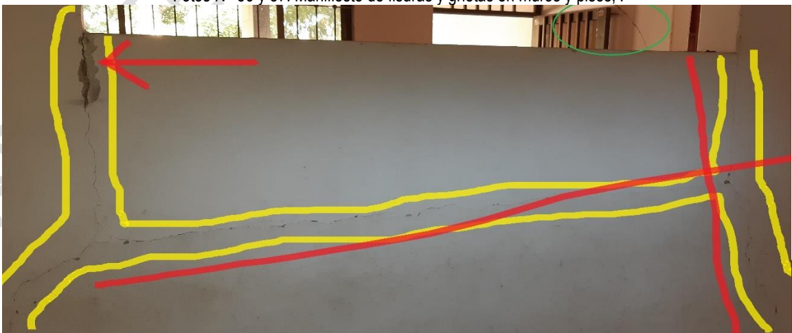
Foto N° 58: Fractura del muro, que soporta vigas, cuchillas para la cubierta manifiesta desprendimientos de los enlucidos
