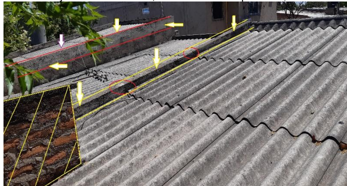
Fotos N° 24 y 25: Estado actual de la cubierta en estudio. Muros sin revoques en laterales y cara superior, plantilla de nivelación en losa de fachada (viga canal) con muestra de deterioro, puesto que no cuenta con algún elemento protector impermeabilizante, se requiere en este caso la demolición total, puesto que los muros no cuenta con la capacidad de carga al igual que la cimentación.
