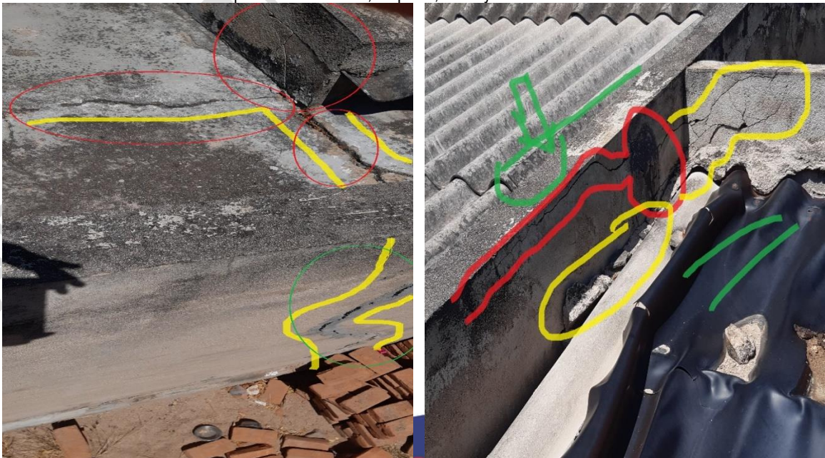
Fotos N° 32 y 33: humedad evidente, rotura y desprendimiento de enlucidos y elementos estructurales, como losas y muros, hasta llegar a la cimentación. Se requiere la demolición de losas, confinar muros y estabilizar el suelo, por medio de zapatas con concreto reforzado.
