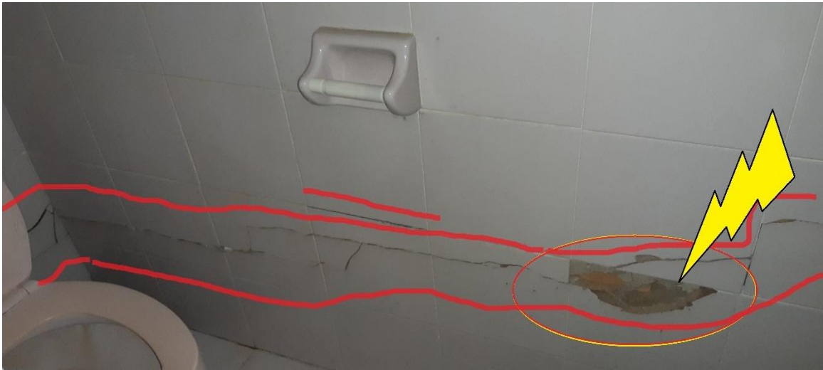
Foto N° 76: Rotura completamente del muro afectando incidentalmente su recubrimiento, (enchape de cerámica).
