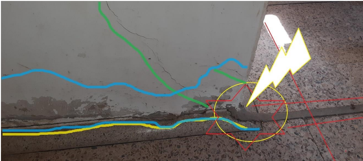
Foto N° 62: Fisuras y grietas en sentido horizontal y diagonal, espesor \leq 15\text{mm} – desprendimientos de enlucidos.
