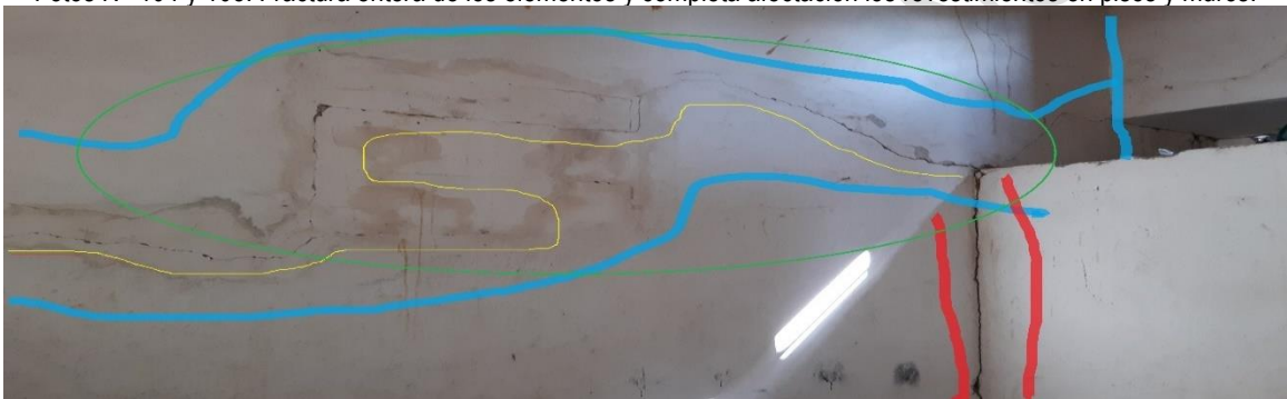
Foto N° 106: Muro afectado por grietas, humedades, y otros, es necesario su demolición para realizar las mejoras.
