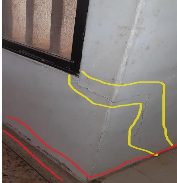
Fotos N° 54 y 55: Grietas y fracturas en muros, en diferentes sentidos, afectaciones en pisos y zocalos.
