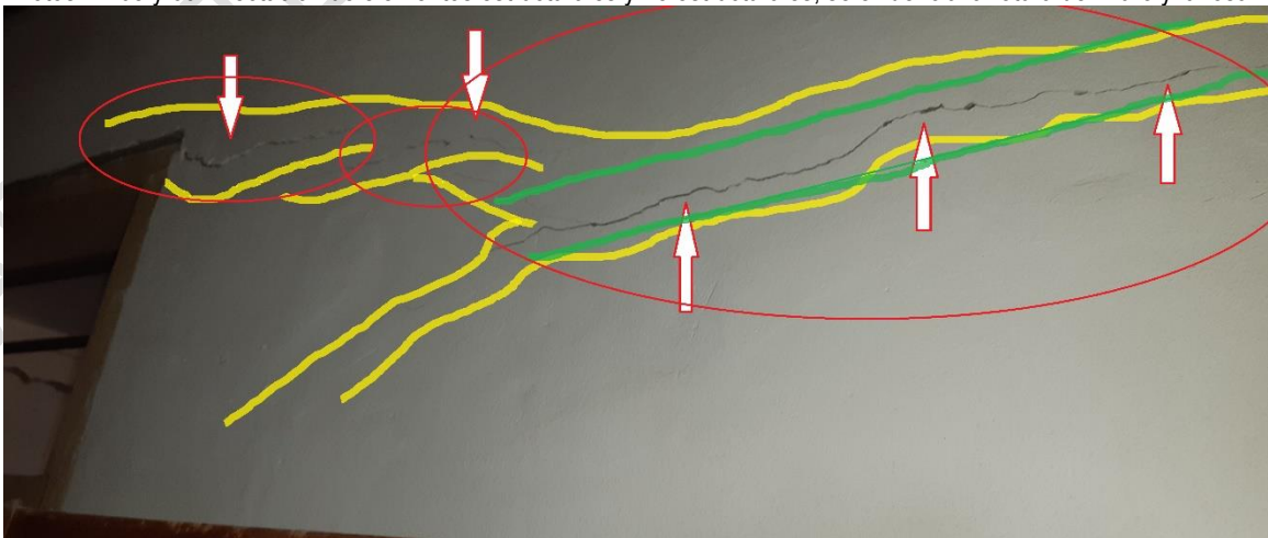
Foto N° 70: Fisuras y grietas horizontales, con desprendimientos de enlucidos y desplazamiento del muro.
