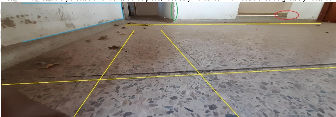
Foto N° 47: Presencia de humedades y agentes biológicos, desplazamiento de los pisos con desprendimientos.
