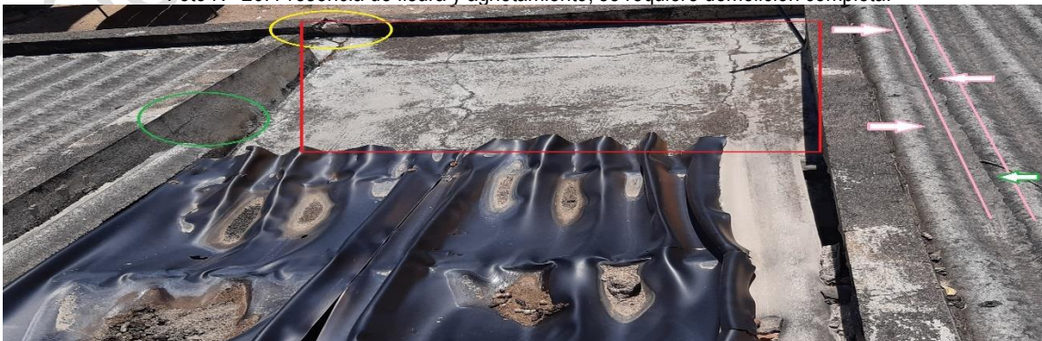
Foto N° 27: Presencia de fisura y agrietamiento, se requiere demolición completa.
