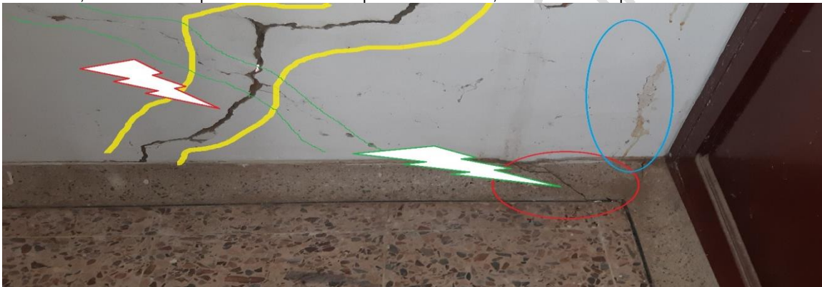
Foto N° 85: Fractura completa del elemento < de 2.5 mm, indica afectación de la cimentación
