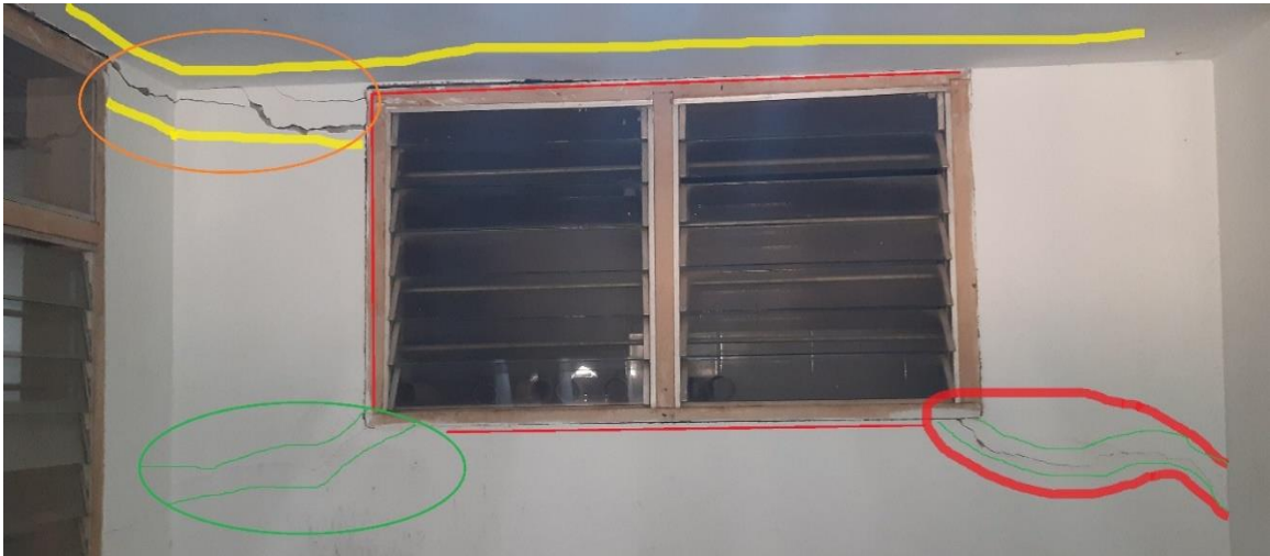
Foto N° 59: Manifestación apreciativa de las patologías, de fisuras, grietas, fracturas, humedades y desprendimientos de los enlucidos, (muro o pared que divide la cámara de aire de las alcobas 1 y 2), debido a las múltiples muestras de patologías, la recomendación para este caso es confinar (columnetas en concreto reforzado) todos los muros de la vivienda, para proveerle más estabilidad a la estructura de la misma
