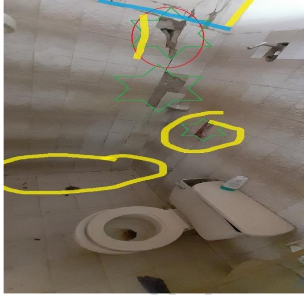
Fotos N° 104 y 105: Fractura entera de los elementos y completa afectación los revestimientos en pisos y muros.
