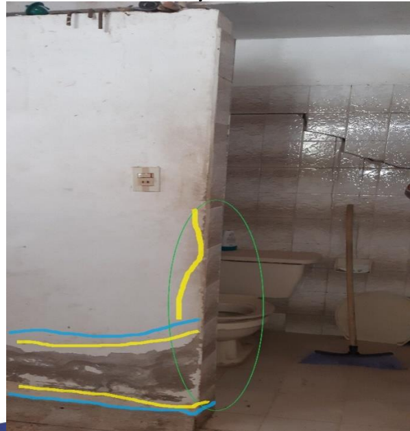
Fotos N° 102 y 103: Clara muestra de la complejidad generada por las patologías presentes, rotura de los elementos humedades y presencia de agentes biológicos, tanto en muros como en pisos y zócalos.
