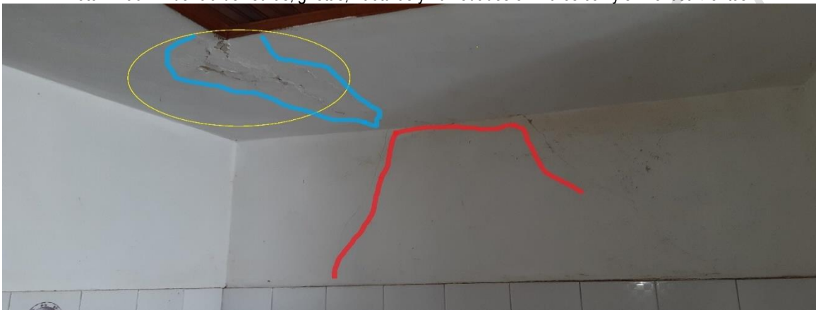
Foto N° 97: Presencia de fisuras, grietas, fracturas y humedades en muros con y sin revestimientos
