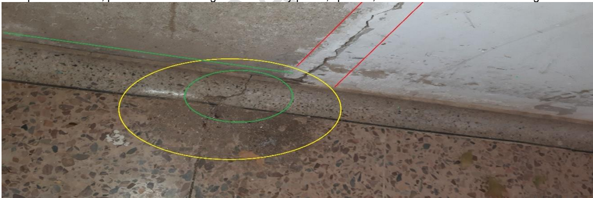
Foto N° 46: Deterioro y afectación evidente de los pisos, zócalos y muros, con manifestaciones de grietas y fracturas.
