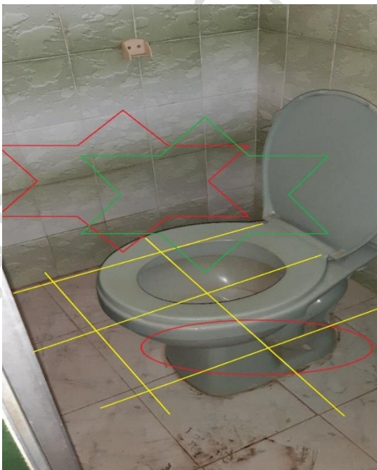
Fotos N° 86 y 87: Deterioro del enchape por fisuras y grietas, cielo raso afectado por la humedad y agentes patógenos.
