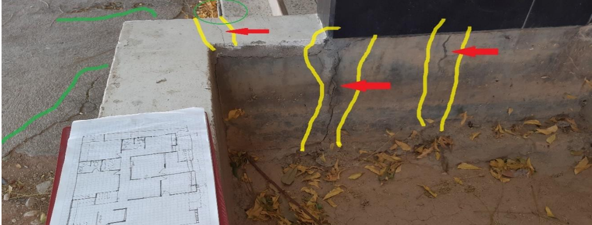
Foto N° 125: Agrietamiento de muros en la jardinera, presencia de humedad.
