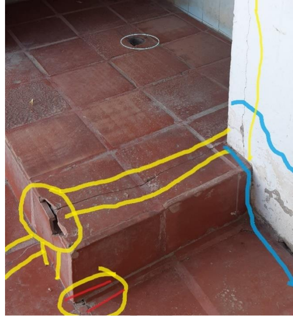
Foto N° 123: Evidentes grietas horizontales en el muro. - Foto N° 124: Agrietamiento de pisos, presencia de humedad
