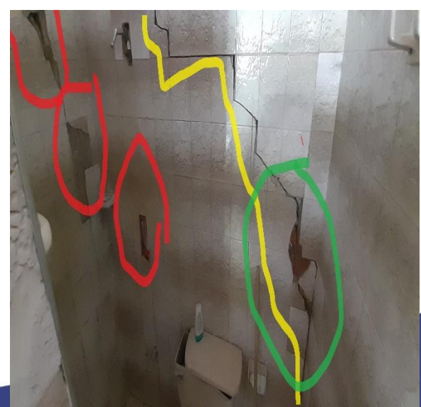
Fotos N° 113 y 114: Compleja manifestación de las patologías nombrada en el cuerpo del informe, afectación de todos los elementos, ya sean estructurales o no.
