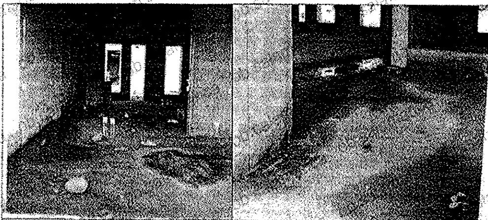
A pesar de los trabajos de impermeabilización persisten las filtraciones ya que no se instalaron adecuadamente las rejillas en los desagües y bajantes.
