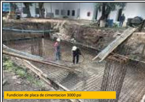
Fundición de placa de cimentación 3000 psi
