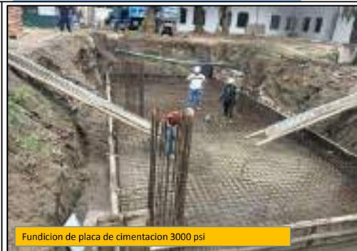
Fundición de placa de cimentación 3000 psi
