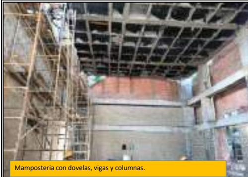
Mampostería con dovelas, vigas y columnas.
