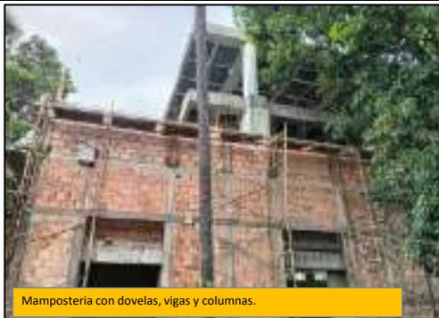
Mampostería con dovelas, vigas y columnas.
