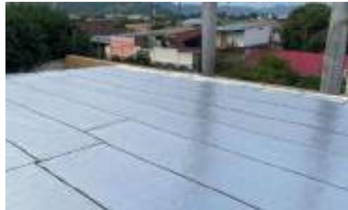
Impermeabilización en la placa cubierta de locales comerciales.
