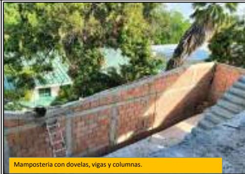
Mampostería con dovelas, vigas y columnas.
