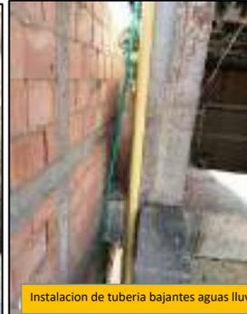
Instalación de tubería bajantes aguas lluvias
