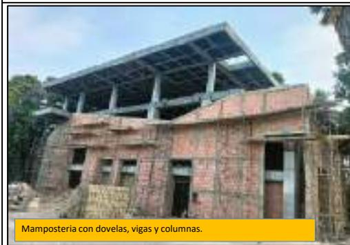
Mampostería con dovelas, vigas y columnas.
