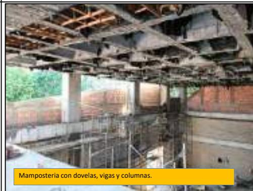
Mampostería con dovelas, vigas y columnas.
