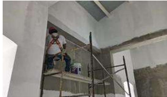
Se realiza recubrimiento con estuco en el salón del taller de apoyo 1 y 2.
