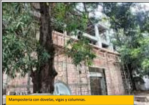
Mampostería con dovelas, vigas y columnas.
