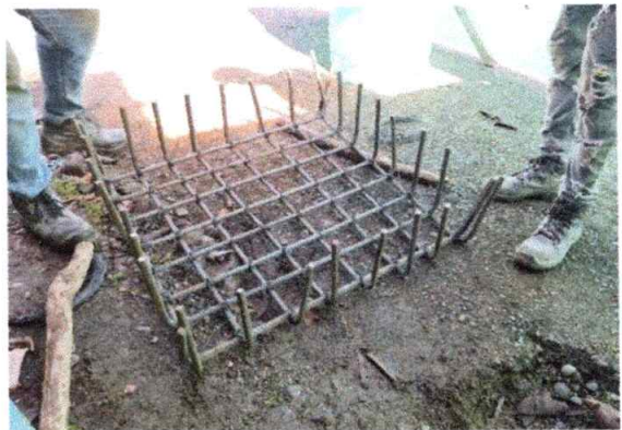
Foto 6: Estructura de acero para dado o zapata en concreto
