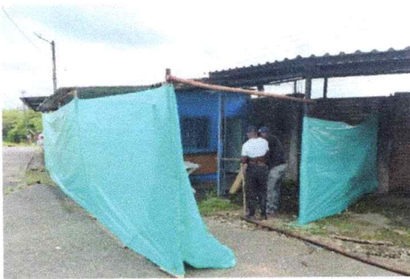
Foto 3: Campamento de obra
