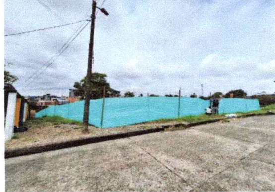
Foto 2: Cerramiento perimetral con tela tejida
