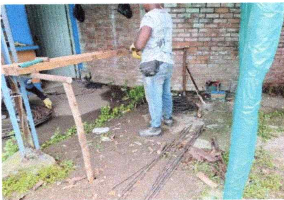
Foto 5: Corte y figurado del acero
