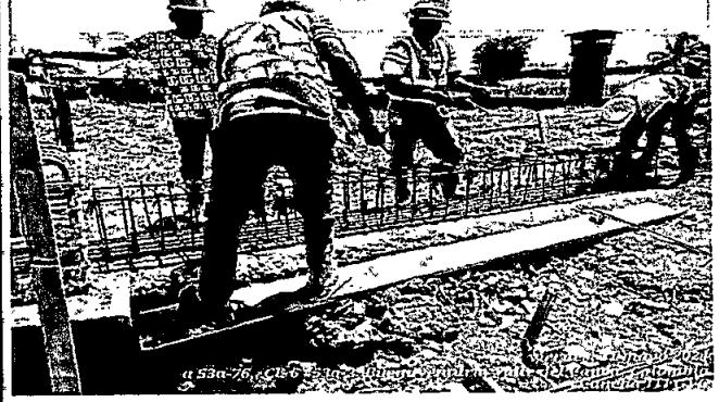
Foto 4: Armado de estructura de acero refuerzo para la viga de cimentación
