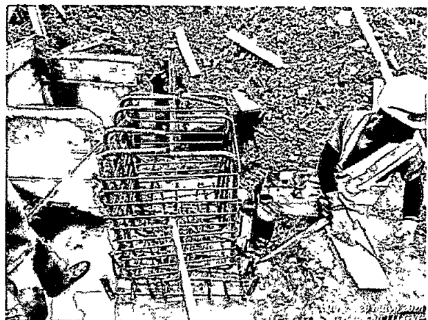
Armado y colocación en sitio de estructura acero refuerzo para zapatas y pedestales en concreto.
