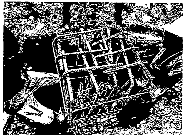
Se realizó corte, figurado, armado y colocación en sitio de estructura acero refuerzo para pilotes, zapatas y pedestales en concreto.
