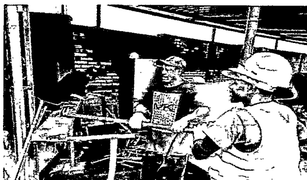
Foto 1: Corte y firado de acero refuerzo para pedestal en concreto.
