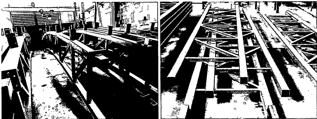
Fotografía 1-2. Fotografía general de elementos inspeccionados
