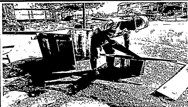
Foto 3: Carpintería en madera para encofrado de pedestales en concreto
