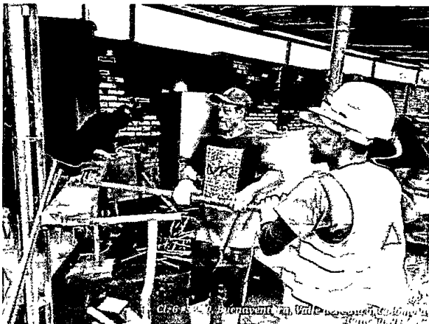
Se realizó corte, figurado, armado y colocación en sitio de estructura acero refuerzo para pilotes, zapatas y pedestales en concreto.
