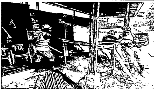
Foto 6: Corte y figurado acero refuerzo flejado para pedestales en concreto.
