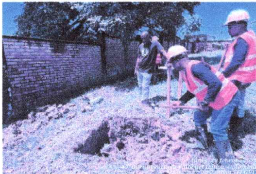
Foto 3: Excavación manual para drenajes
