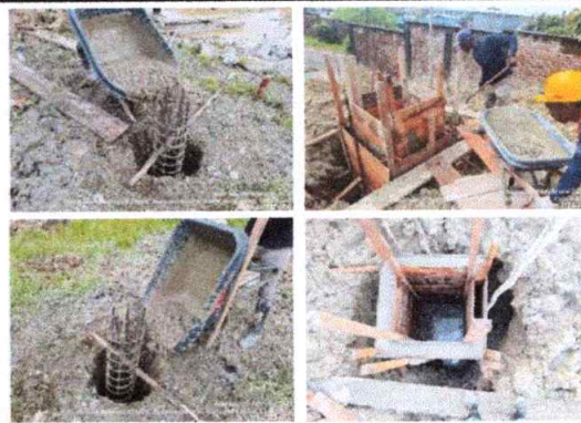
Foto 6: Fundición de cajas de inspección y pilotes en concreto.
