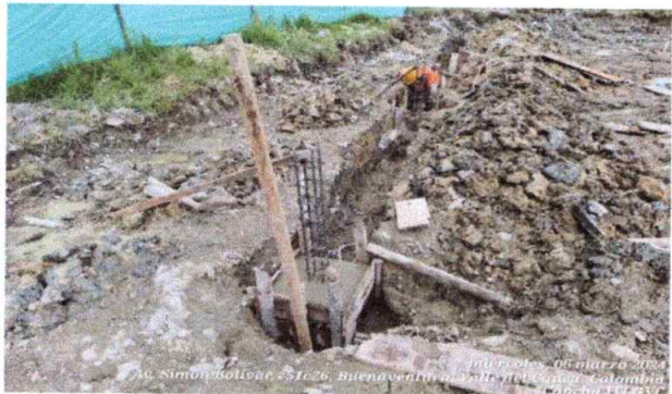
Foto 3: Fundición de zapatas
