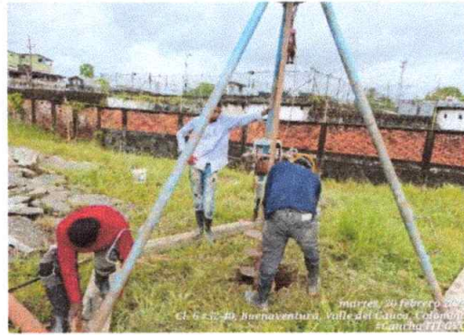
Foto 2: Excavación a mano para pilotes.
