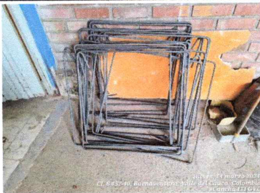
Foto 1: Corte, figurado y armado estructura de acero para dados
