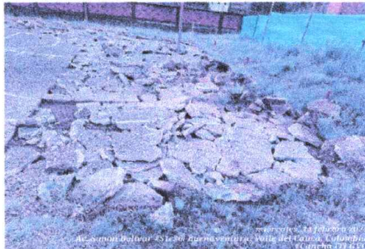
Foto 4: Demolicion de placa concreto existente
