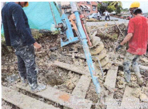
Excavación manual y mecánica para fundición de pilotes de la malla contra impacto
