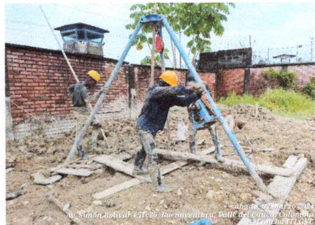
Excavación manual y mecánica para fundición de pilotes de la malla contra impacto
