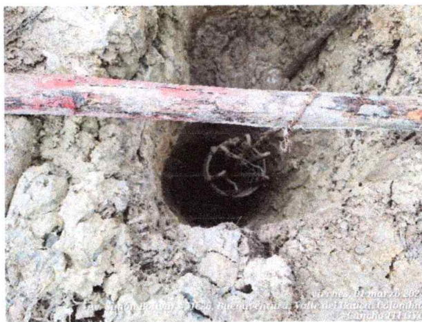
Fundición de pilotes en concreto de la malla contra impacto.
