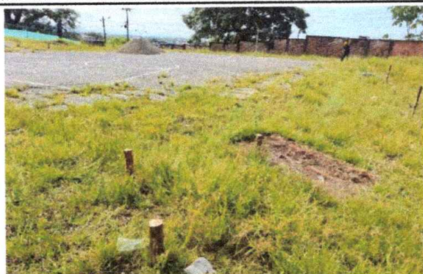
Foto 5: Replanteo de puntos para pilotes y malla contra impacto
