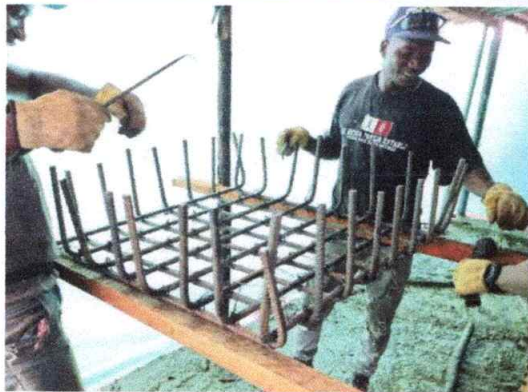
Foto 1: Armado acero refuerzo para estructura en concreto (dados)
