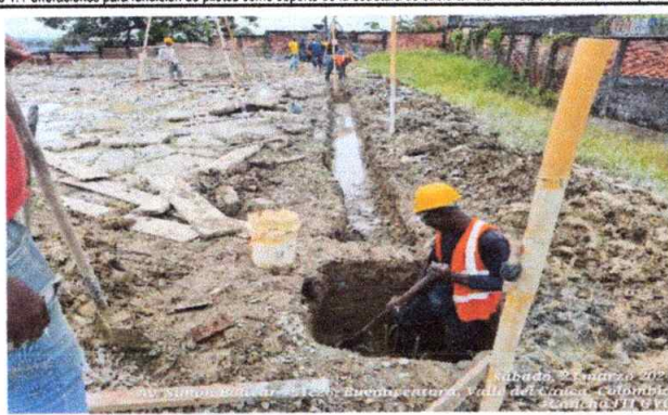
Foto 3: Excavación manual para zapatas y vigas
