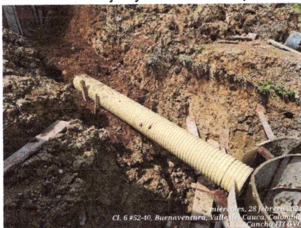
Instalación de tuberías sanitarias de 10" y 12"
