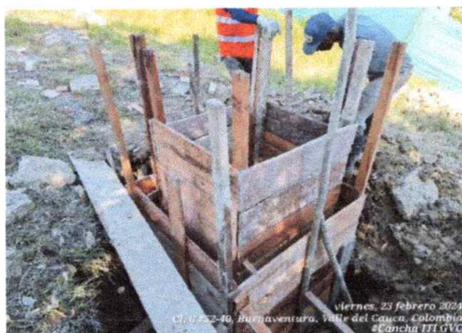
Foto 5: Encofrado de formaletas para fundición de cajas de inspección.
