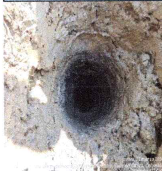
Foto 1: Perforaciones para fundición de pilotes como soporte de la estructura de cubiertaFoto 1: Instalación de tuberías para
