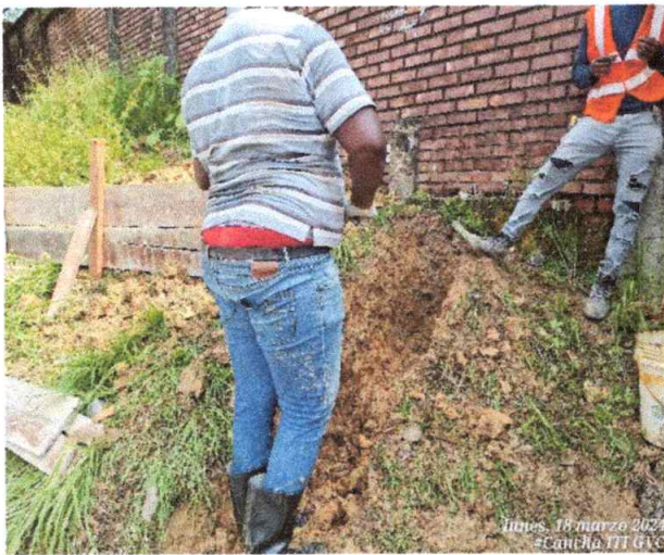
Excavación manual para instalación de tubería sanitaria
