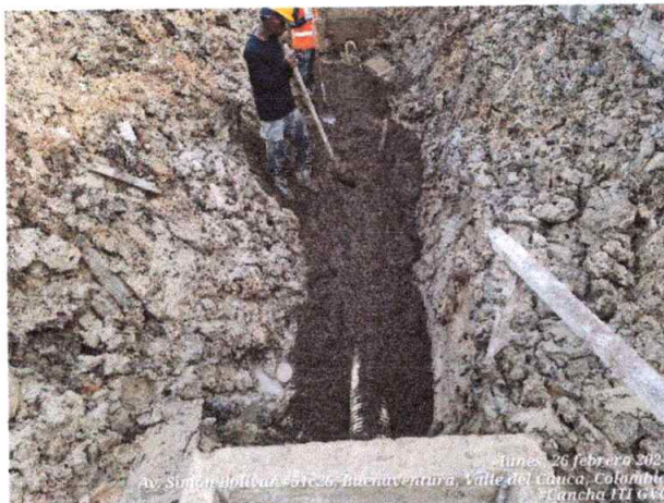
Relleno con material de río.
