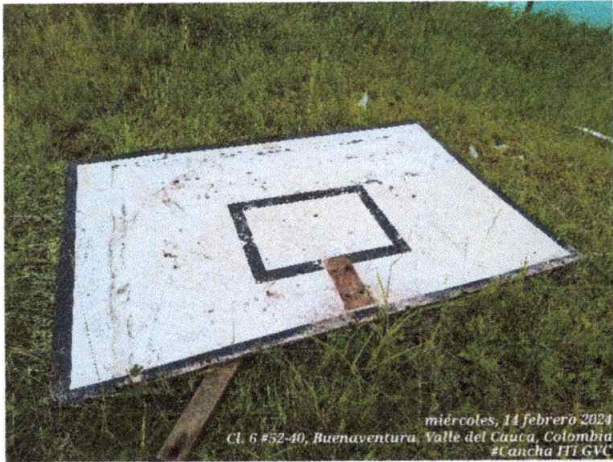
Desmonte de poste de juegos existente
