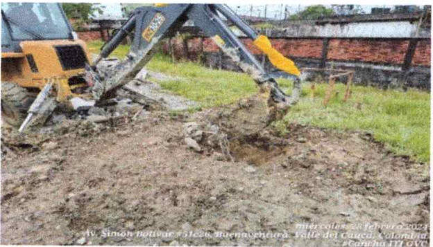
Foto 3: Retiro de pilote fundido
