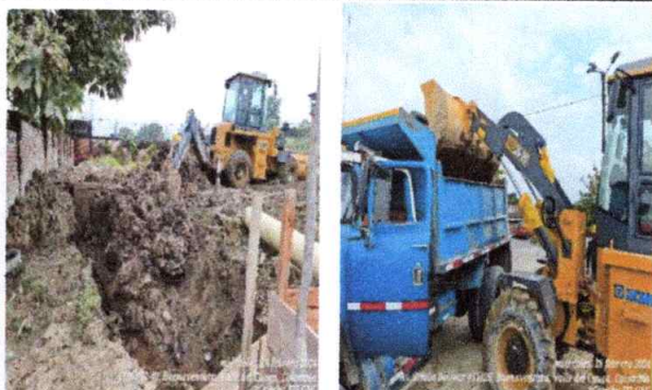
Foto 4: Relleno con material de sitio y retiro de material de sitio
