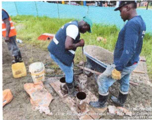
Toma de muestra del concreto para pilotes de la malla contra impacto
