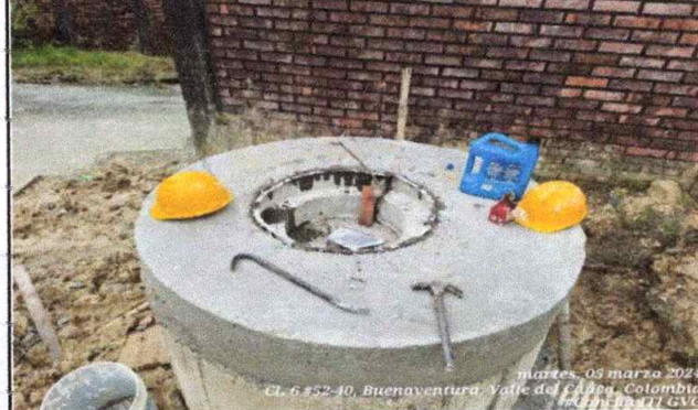
Foto 6: Fundición de tapa de concreto de la camara de inspección
