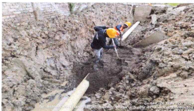
Foto 1: Instalación de tuberías para drenajes
