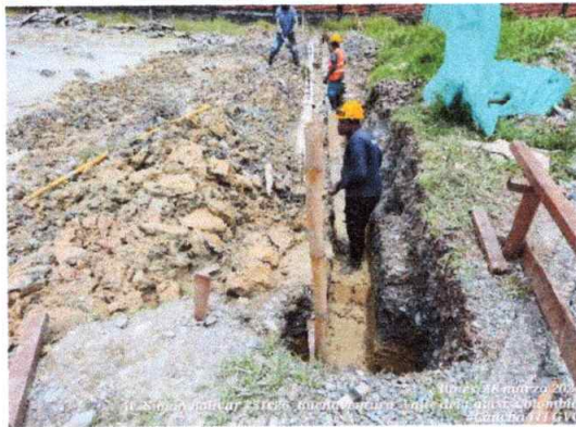
Foto 2: Excavación a mano para filtro
