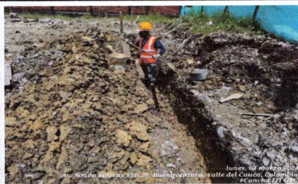
Foto 2: Excavación manual para zapatas y viga de cimentación de la malla contra impacto
