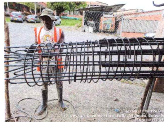
Foto 6: Armado y flejado de hierro para pilotes largo de 7,30 mts.
