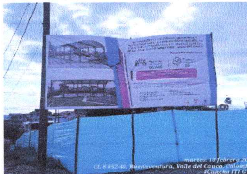
Foto 2: Instalacion de Valla Informativa de Obra
