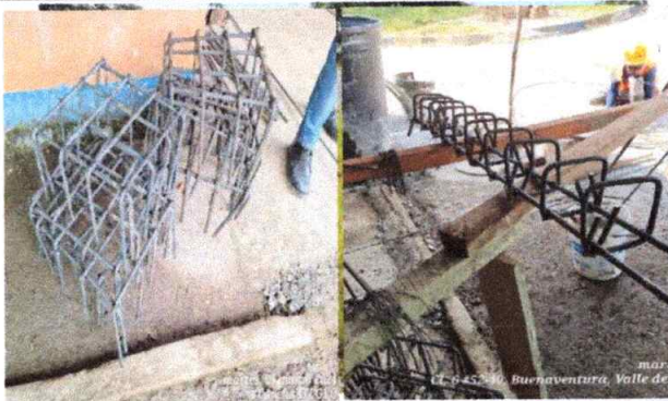
Foto 5: Acero refuerzo flejado y armado de columnetas, zapatas y vigas
