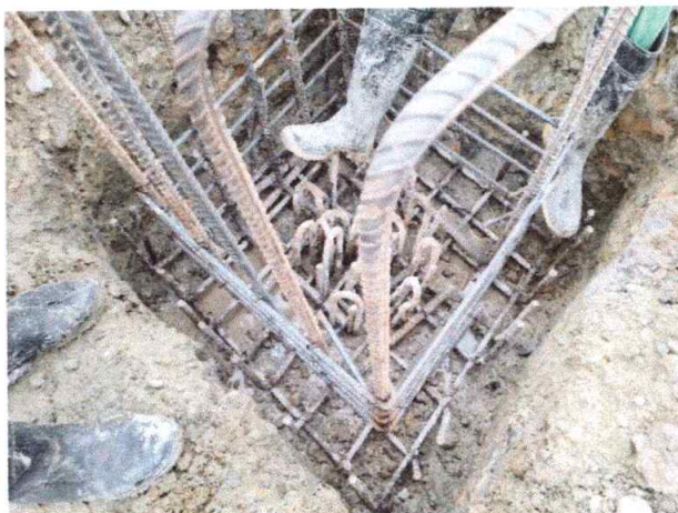
Colocación de acero refuerzo de zapata y pedestal y fundición de zapata en concreto.
