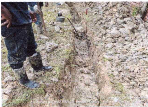
Foto 3: Excavación a mano para instalación de tuberías sanitarias.
