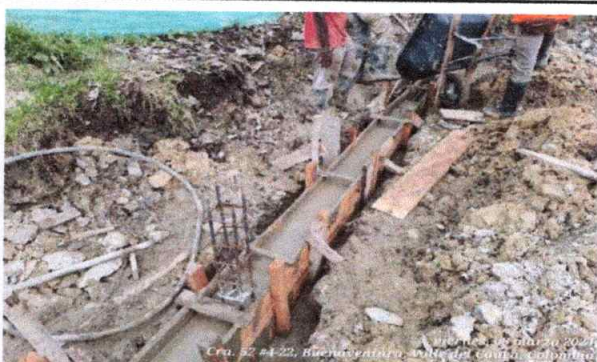
Foto 4: Fundición de viga de cimentación
