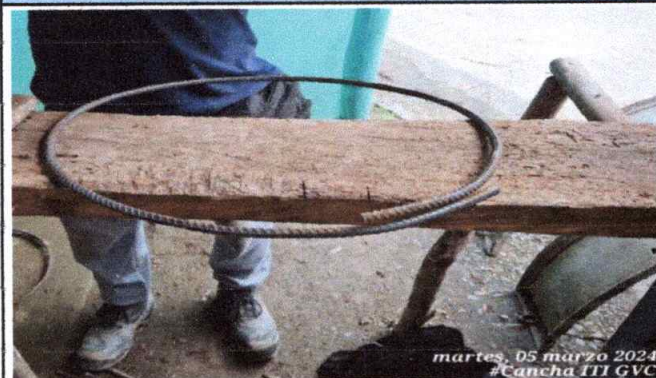
Foto 1: Corte, figurado y armado de estructura de acero para tapa de la cámara
