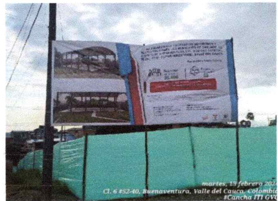
Foto 2: Instalación de Valla Informativa de Obra
