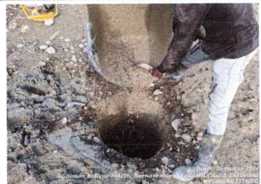
Foto 2: Fundición de pilotes en concretos de 7mts
