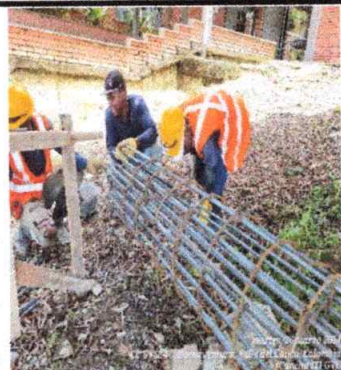
Foto 5: Estructura de acero refuerzo para pilotes de 7mts
