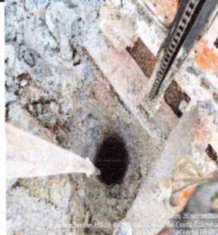
Foto 1: Perforaciones para fundición de pilotes como soporte de la estructura de cubiertaFoto 1: Instalación de tuberías para
