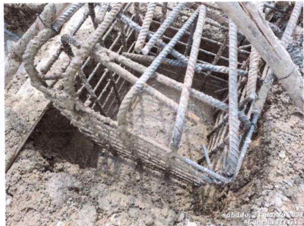
Colocación de acero refuerzo de zapata y pedestal y fundición de zapata en concreto.
