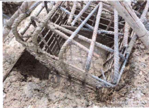
Foto 6: Fundición de zapatas en concreto
