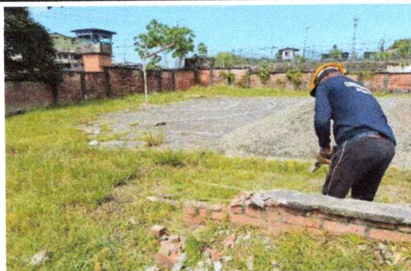
Foto 6: Demoliciones de muros existentes
