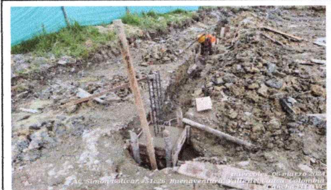
Foto 3: Fundición de zapatas
