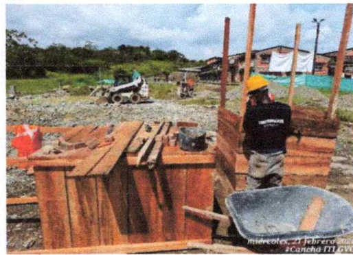
Foto 4: Carpintería en madera para formaletas.
