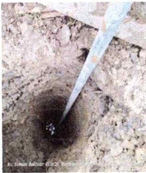
Foto 5: Excavación manual para pilotes y fundición de estos
