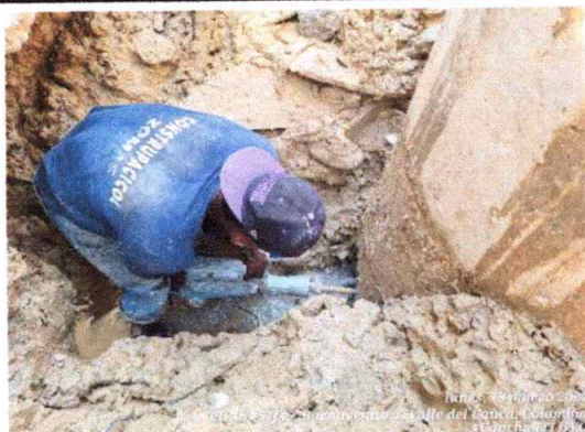
Foto 3: Demolicion a mano de camara para instalacion de tuberias sanitarias.
