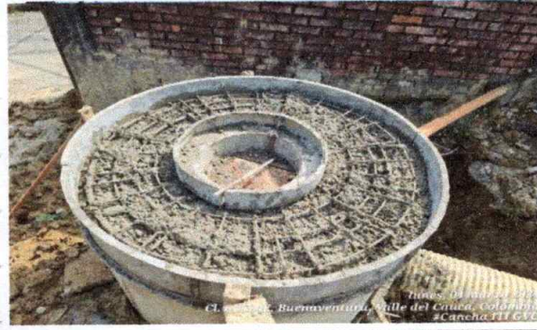
Foto 6: Fundición de tapa de concreto de la cámara de inspección
