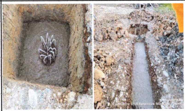
Foto 4: Fundición de solados para zapatas y vigas
