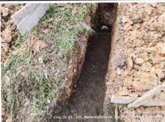
Foto 5: Instalacion de filtro de la tubería PVC SANITARIA.
