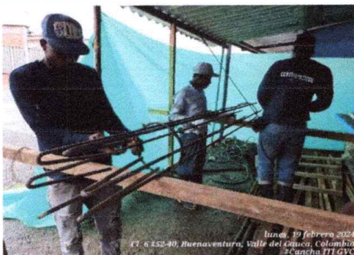
Foto 1: Corte, figurado y armado estructura de acero para pilotes (2,5mts)
