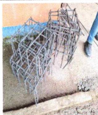
Foto 5: Acero refuerzo flejado y armado de columnetas, zapatas y vigas
