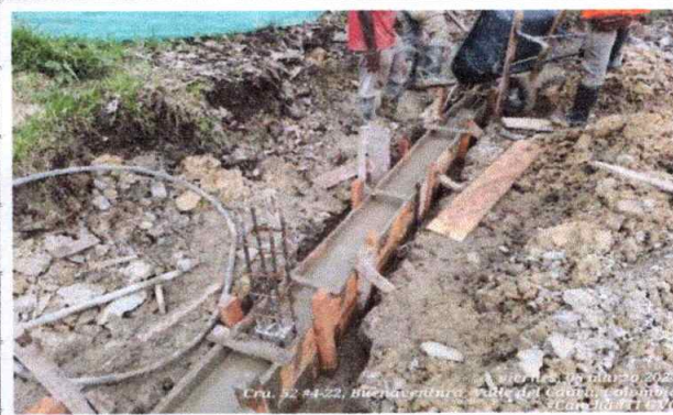
Foto 4: Fundición de viga de cimentación
