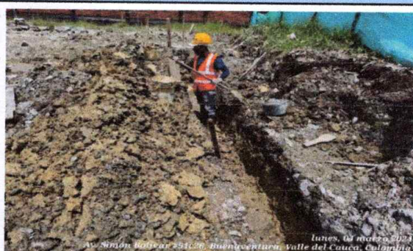
Foto 2: Excavación manual para zapatas y viga de cimentación de la malta contra impacto
