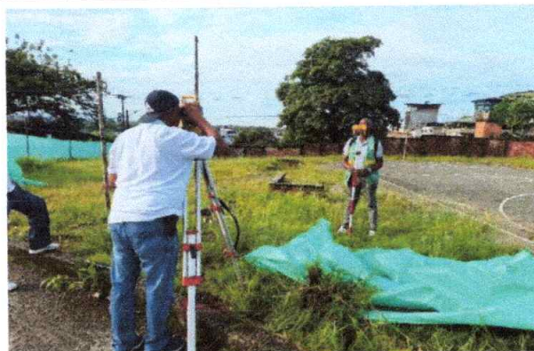
Foto 4: Localización de puntos para pilotes y malla contra impacto
