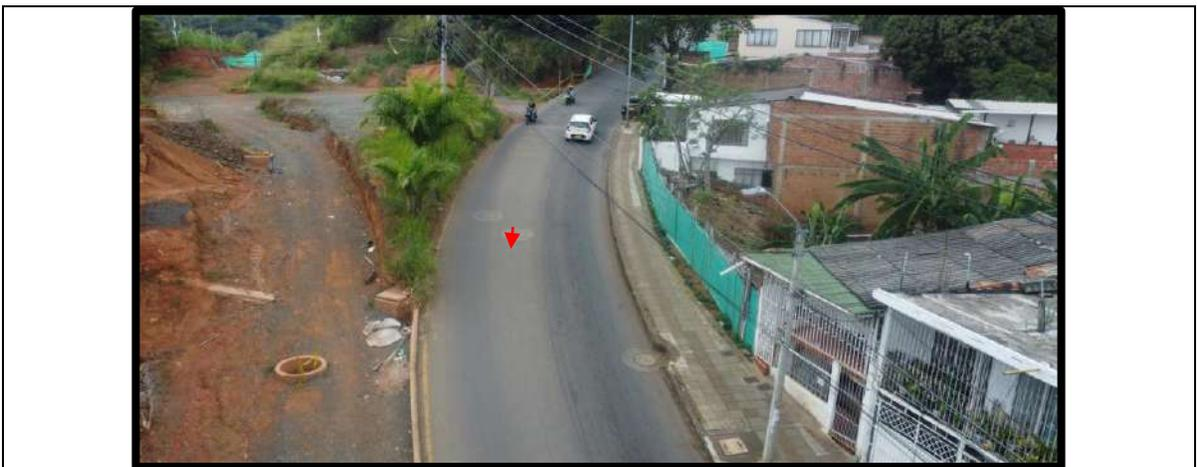
**Fotografía No 03:** vía sin demarcación horizontal ni demarcación longitudinal, tampoco contaba con señalización vertical de prevención por obra, ni de obligación, para la fecha de la inspección, ni para la fecha del accidente, la vía se encuentra en obra por el sardinel derecho sentido norte- sur, cabe aclarar que para la fecha de los hechos también estaba en obra, pero con una mayor profundidad de excavación.
