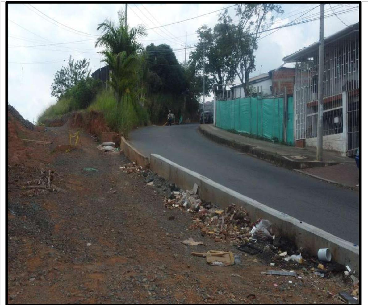
**Fotografía No 05:** Se realiza toma panorámica en plano general, tomada bajo iluminación natural, donde se evidencia el tramo de vía, en material suelto, sin algún tipo de señalización dispuesta en la vía.
