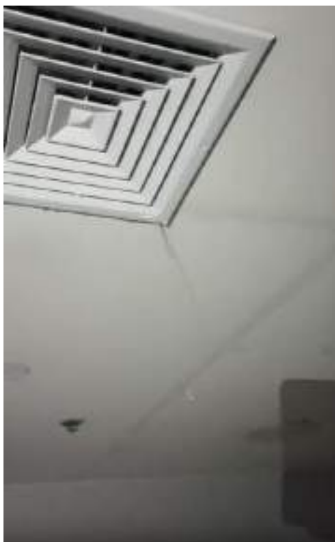
Imagen 2 caída de agua por rejilla aire y lámparas
