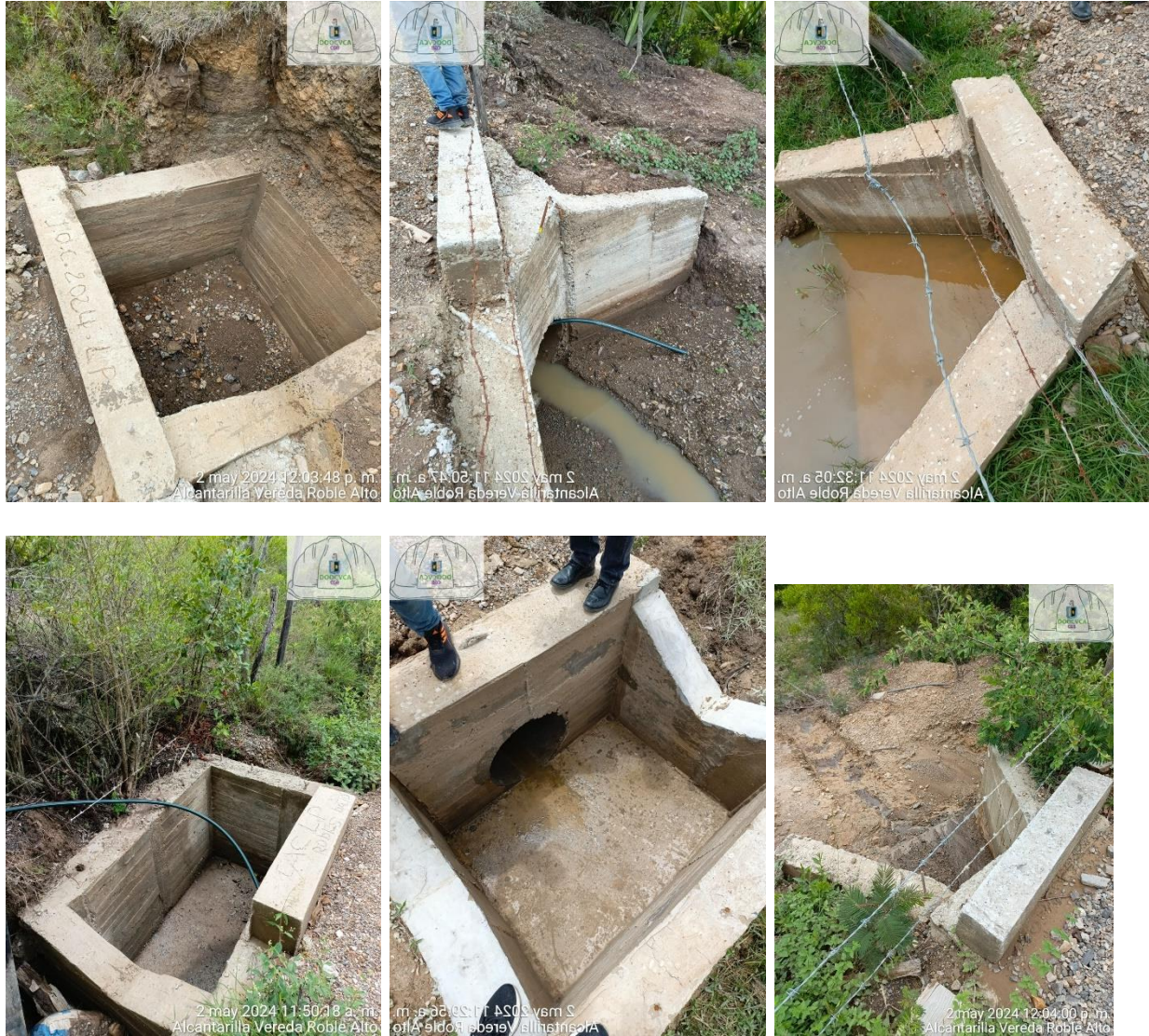
FOTOGRAFÍAS 10, 11, 12, 13, 14, 15: ALCANTARILLAS EJECUTADAS EN LA VEREDA ROBLE BAJO VILLA E LEYVA. (FOTOGRAFÍAS VISITA DE FISCALIZACIÓN).
