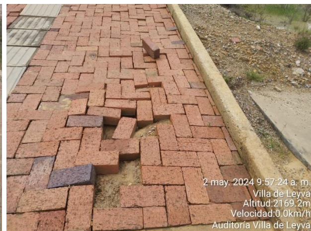
FOTOGRAFÍAS 26, 27, 28, 29, 30: DAÑOS EN ADOQUÍN, LEVANTAMIENTOS, ASENTAMIENTOS, DESNIVEL. (FOTOGRAFÍAS VISITA DE FISCALIZACIÓN).
