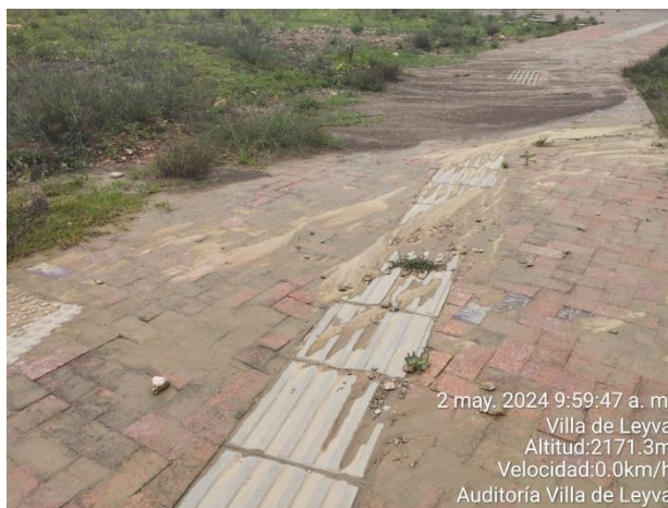
FOTOGRAFÍAS 26, 27, 28, 29, 30: DAÑOS EN ADOQUÍN, LEVANTAMIENTOS, ASENTAMIENTOS, DESNIVEL. (FOTOGRAFÍAS VISITA DE FISCALIZACIÓN).
