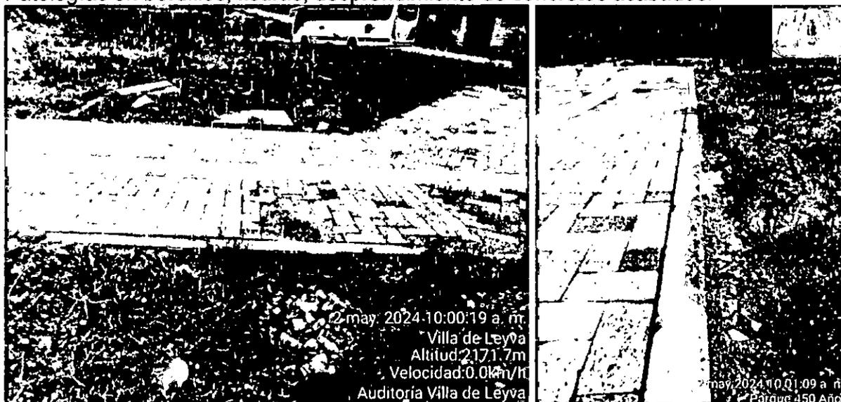
Fisuras y desgaste de acabado en bordillos. (FOTOGRAFÍAS VISITA DE FISCALIZACIÓN).
