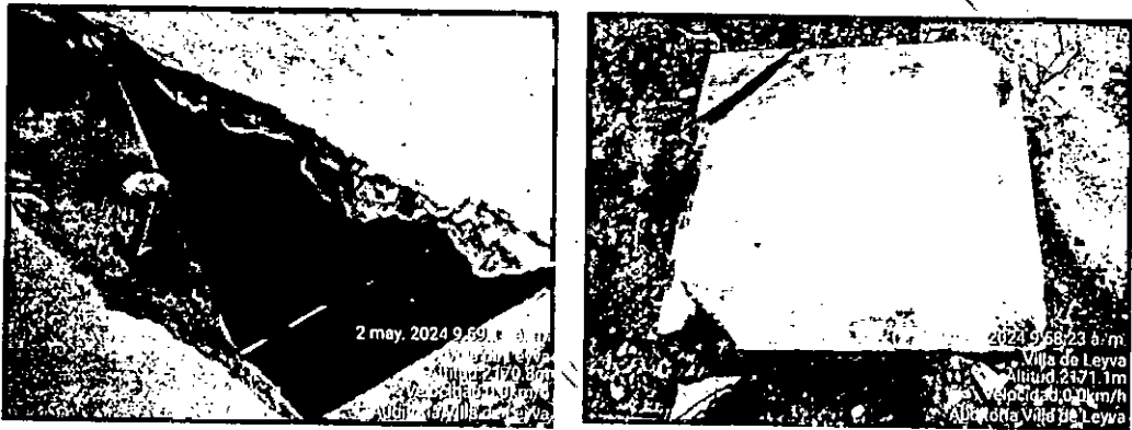
Fisuras y desgaste de acabado en bordillos. (FOTOGRAFÍAS VISITA DE FISCALIZACIÓN).
