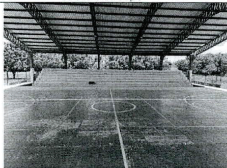
Se observan las rampas de acceso a las baterías de baños, ubicadas en los extremos de las graderías
