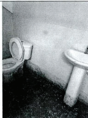
Baterías de baños para mujeres inundados. Obsérvese el nivel máximo de inundación en las paredes
