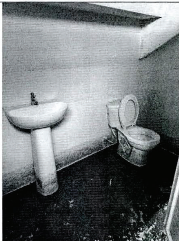
Baterías de baños para hombres inundados. Obsérvese el nivel máximo de inundación en las paredes
