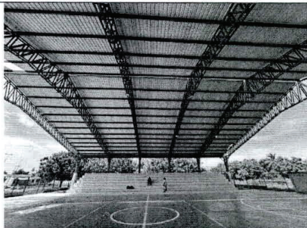
Al fondo se observa las graderías, y debajo de ella se encuentran las baterías de baños, las cuales están en un nivel inferior al de la cancha múltiple
