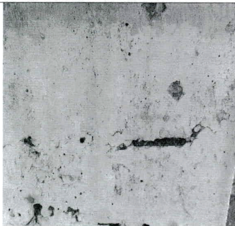
Acero de refuerzo expuesto en una de las columnas rectangulares de concreto ubicada sobre el área de tarima
