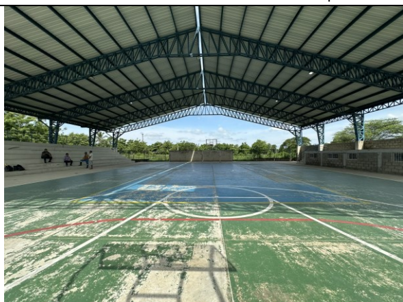
Deterioro de la demarcación de pintura acrílica para cancha multifuncional
