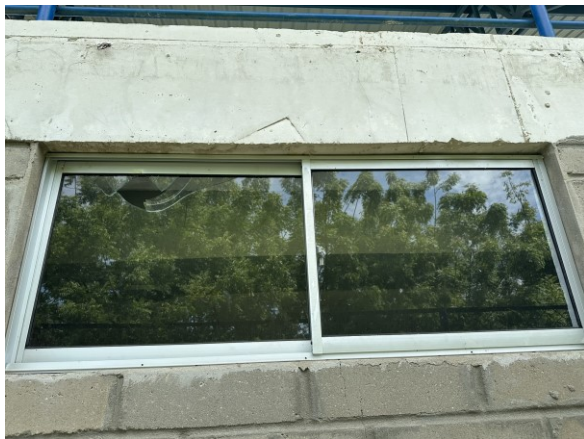
Vidrios rotos en una de las ventanas corrediza de la batería de baños de hombres
