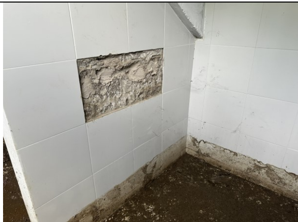
Desprendimiento del enchape para baños en cerámica en el baño de hombres. Obsérvese el nivel máximo de inundación en las paredes
