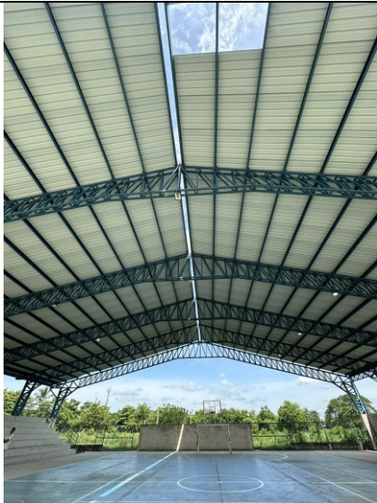
Ausencia parcial de láminas de la cubierta en teja termoacústica trapezoidal
