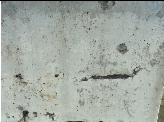
Acero de refuerzo expuesto en una de las columnas rectangulares de concreto ubicada sobre el área de tarima
