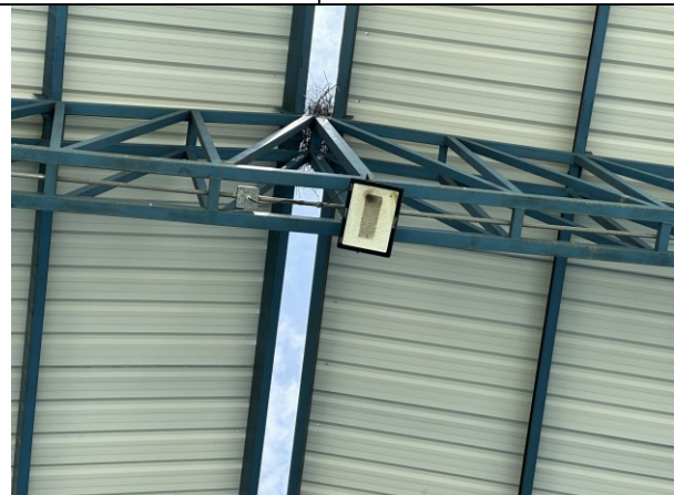
Cubierta sin caballetes. Lámpara LED Antares de 100W y 220 V de sobreponer fundida
