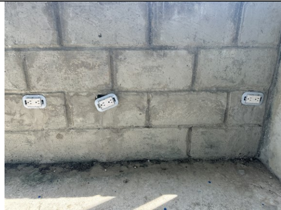
Tomacorrientes dobles 120 V sin tapas metálicas
