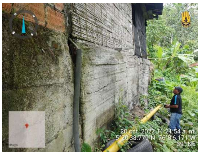
Foto 7. Registro fotográfico donde se evidencia estructura de la vivienda.
