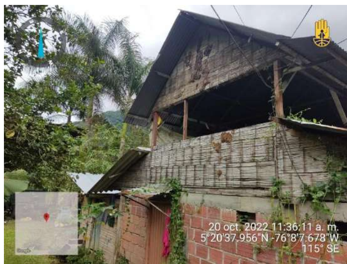
Foto 10. Registro fotográfico donde se evidencia estructura de la vivienda.
