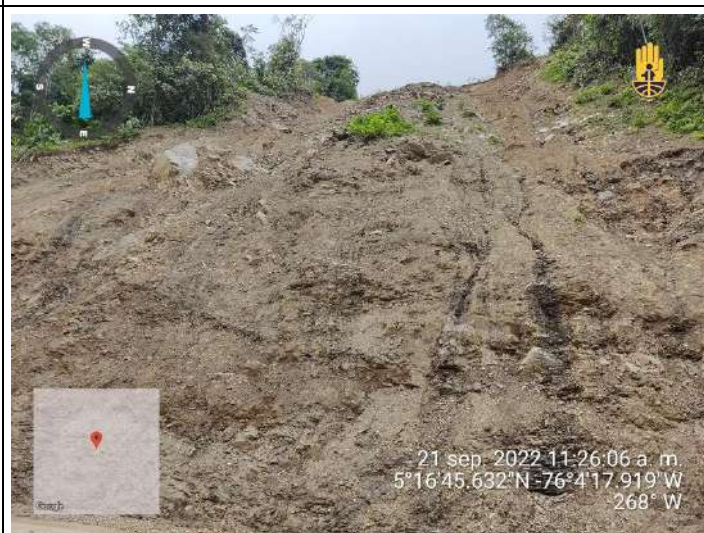
Foto 12. Vista desde la basa del deslizamiento, sobre la Vía Pueblo Rico – Santa Cecilia.
