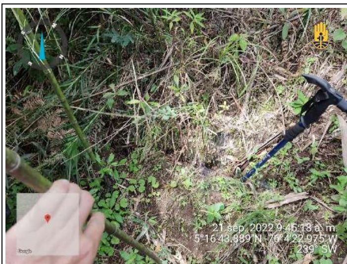
Foto 5. Registro de una de la grietas paralelas a la corona del deslizamiento.
