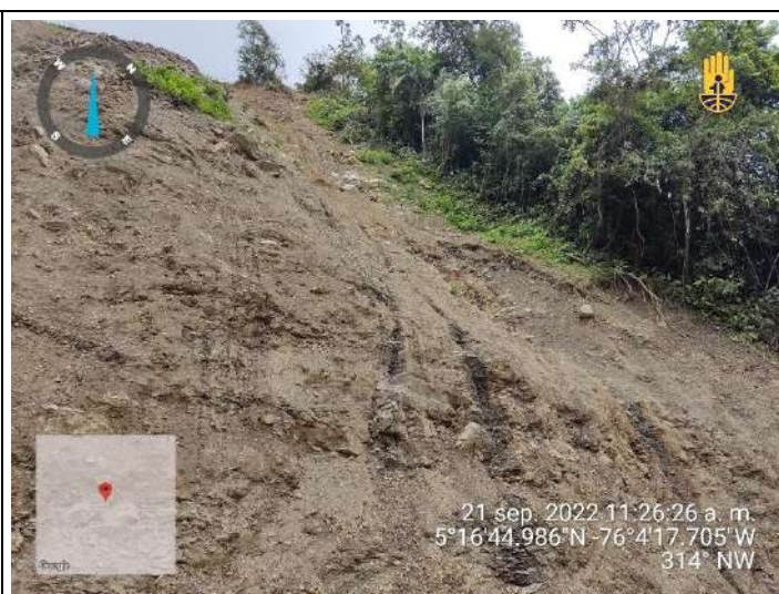
Foto 14. Vista desde la basa del deslizamiento flanco derecho, sobre la Vía Pueblo Rico – Santa Cecilia.
