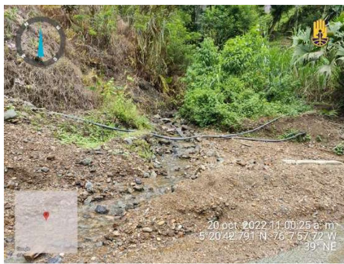
Foto 2. Registro fotográfico donde se observa afluente NN el cual está circulando por encima de la vía.
