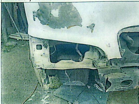
Imagen 4, se observa el conjunto de las farolas lado derecho destruidas.
